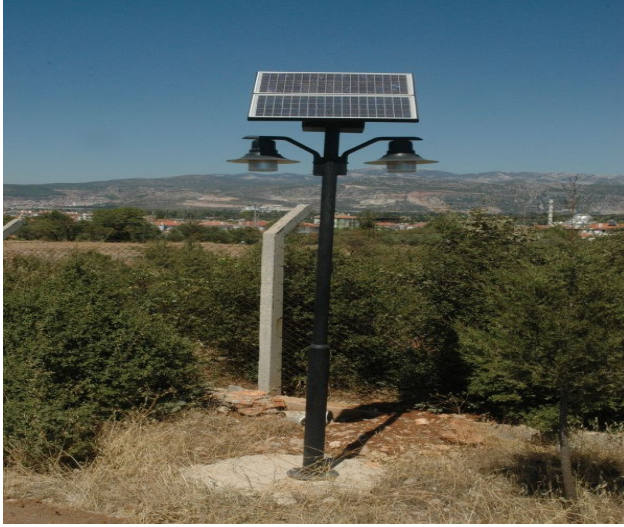
Şekil 1.15. Muğla Üniversitesi kampüs içi yürüyüş yolu aydınlatma sistemi. (Anonim d, 2006)
