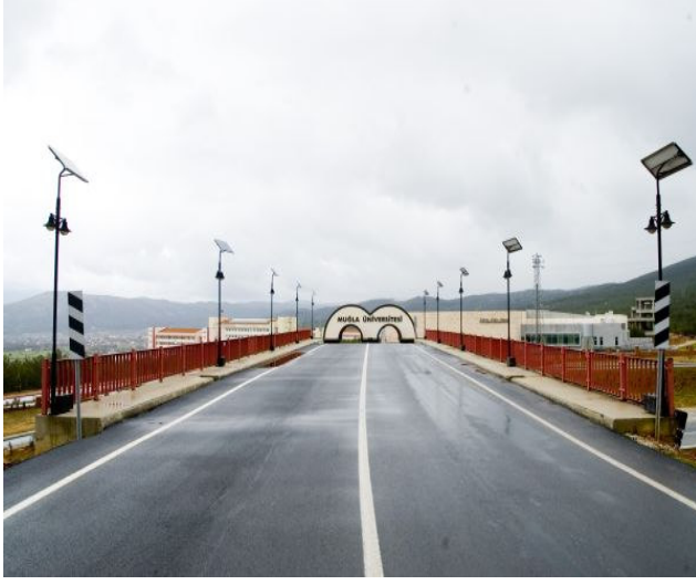
Şekil 1.14. Muğla Üniversitesi Sıtkı Koçman Köprüsü aydınlatma sistemi. (Anonim d, 2006)
