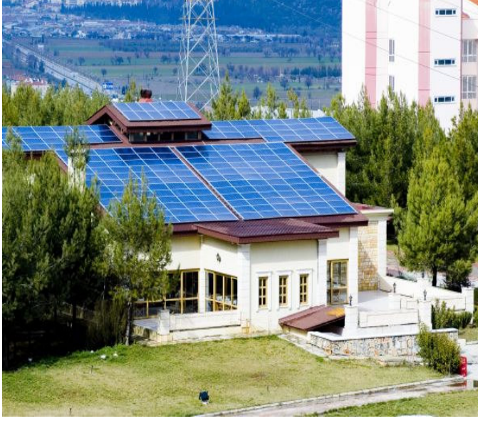
Şekil 1.12. Muğla Üniversitesi Türk Evi restoran çatısına entegre 26 KWp fotovoltaik güç sistemi. (Anonim d, 2006)
