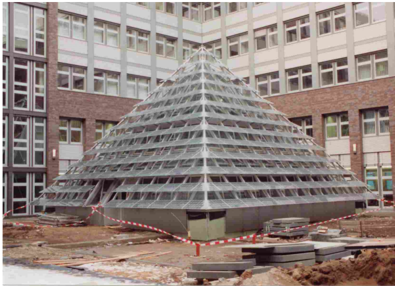
Şekil 1.20. Piramit şeklinde bir bina ile bütünleşik güneş enerjisi üretim sistemi (BIPV-Building Integrated Photovoltaic Systems), (Hammer, 2006)
