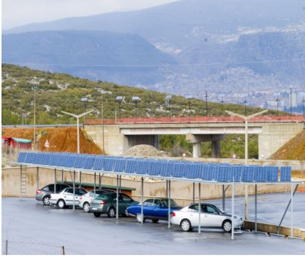
Şekil 1.13. Muğla Üniversitesi otopark çatısına entegre 15kWp fotovoltaik güç sistemi. (Anonim d, 2006)
