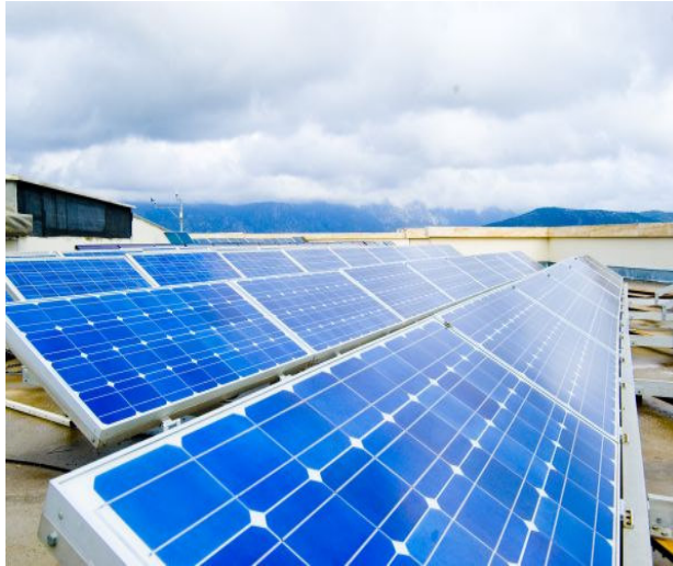
Şekil 1.10. Muğla Üniversitesi Merkez Kütüphanesi çatısına entegre 10 kWp fotovoltaik güç sistemi. (Anonim d, 2006)
