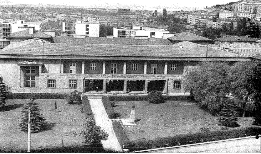
Resim 29: Ankara Devlet Konservatuvarı eski binasının genel görünüşü (Bugün Mamak Belediyesi'ne verilmiştir) (Müzik Ansiklopedisi, cilt 1, s.72).
