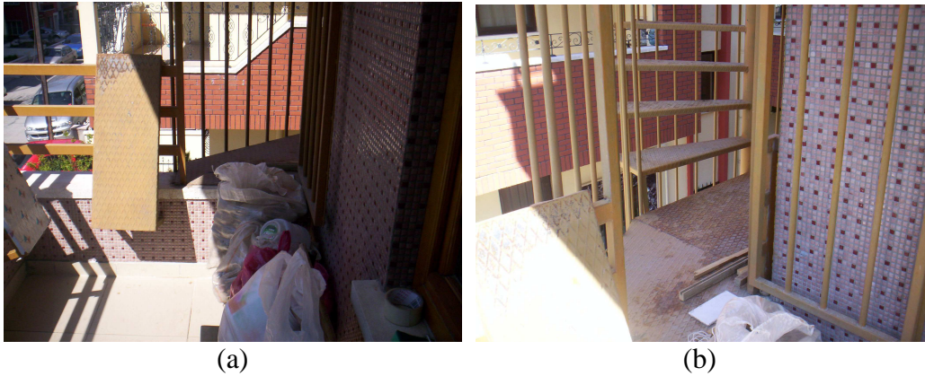
Resim 3.10.a. Yangın merdiveni giriş eşiği, b. Yangın merdiveni genel görünümü [56]
