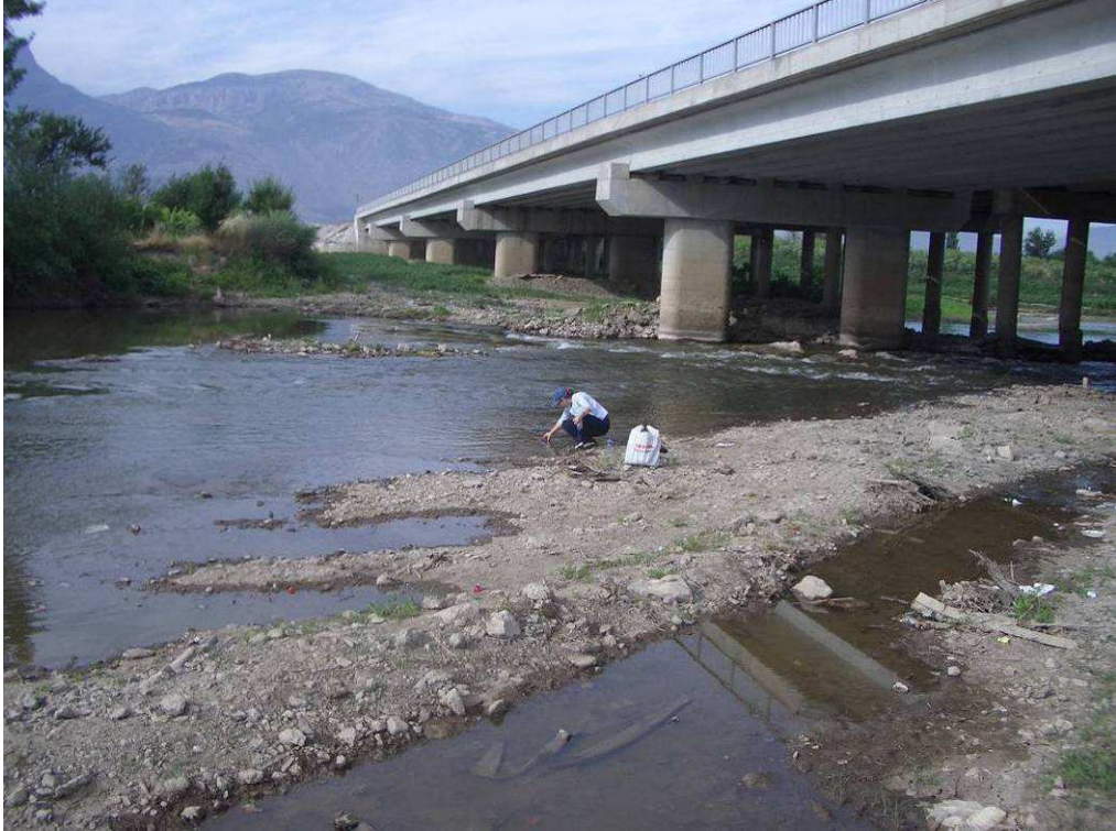
Şekil 4.1.1.1.1: İstanbul Yolu Gediz Köprüsüne ait genel görünüş.
