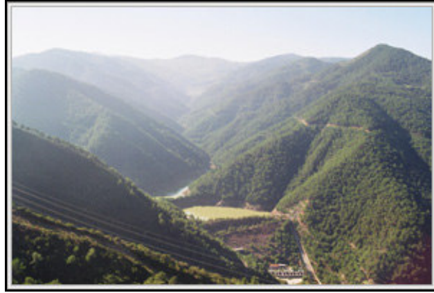
Şekil 2. Balçova Cengiz Saran Barajı (DSİ, 2005)
