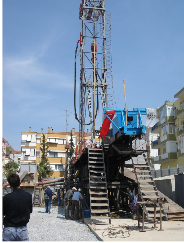
Foto-9 BD-11 Sıcak Su Kuyusu Sondajı
