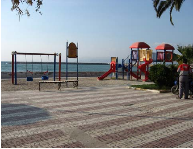
Şekil 4.49. Şehit Ahmet Şengülen Parkı çocuk oyun alanındaki oturma elemanları, yer belirleyici ve çocuk oyun elemanları
