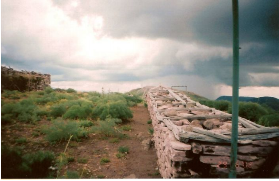
Fotoğraf 3: Hozat Sarı Saltık türbesi, üstten görünüm
