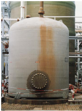
Şekil 3.7 25 yıllık HCl üretim ekipmanı(44 m 3 ), (Chemical Report, 2005).
