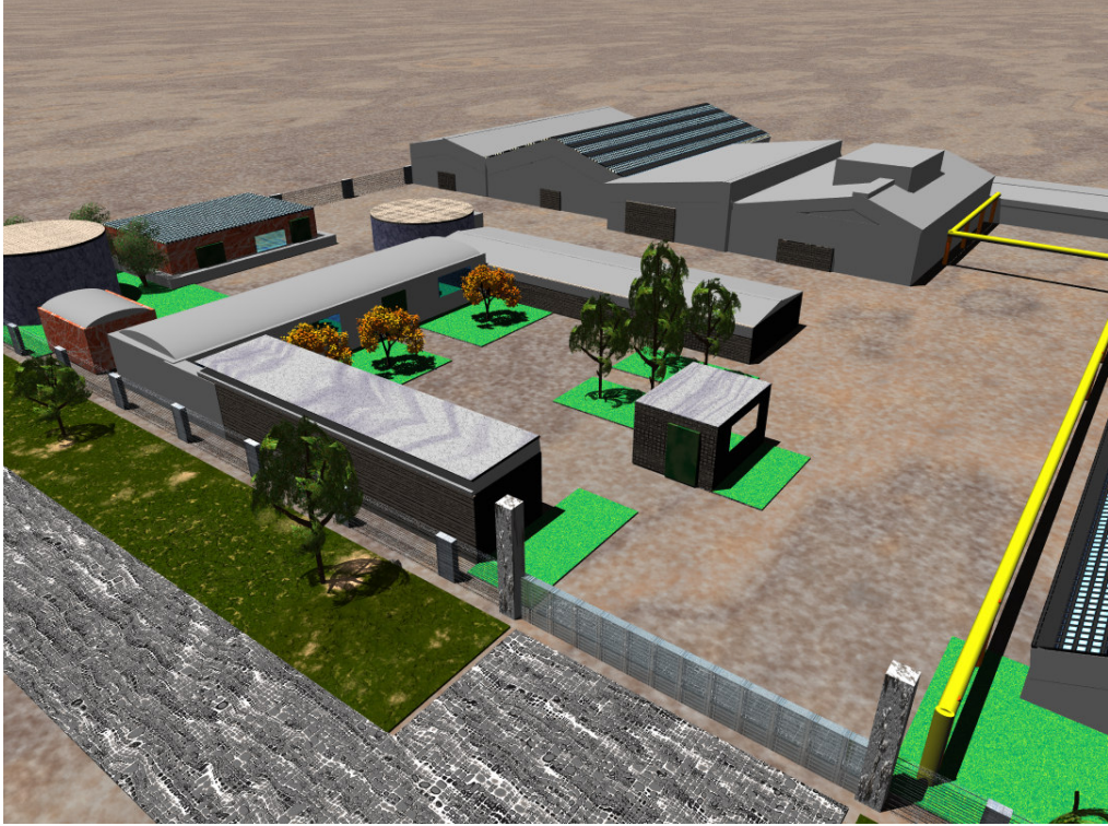
Şekil 4.20 Tesisin genel görüntüsü, asit dışarıdan boru hattıyla tesise getirilmektedir.
