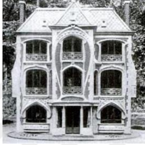
Şekil 6. Heliotropik ev ön görünüşü
