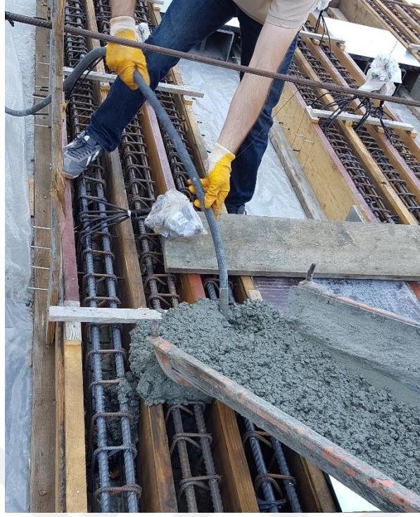
Şekil 2.4 Beton dökümü ve vibrasyon işlemleri
