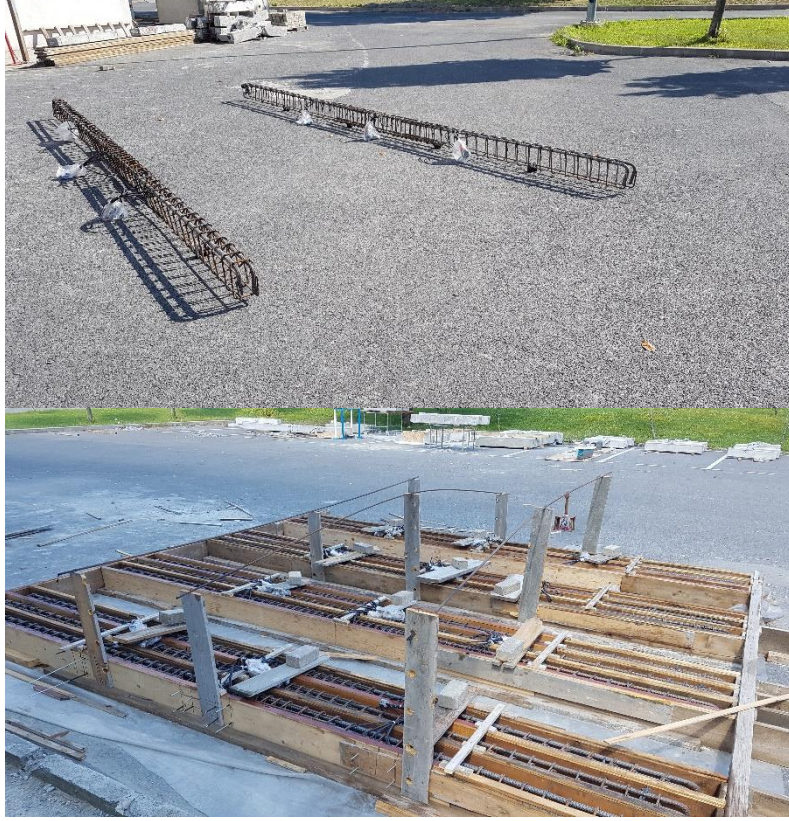
Őekil 2.3 Donatıların kalıplara yerleřtirilmesi
