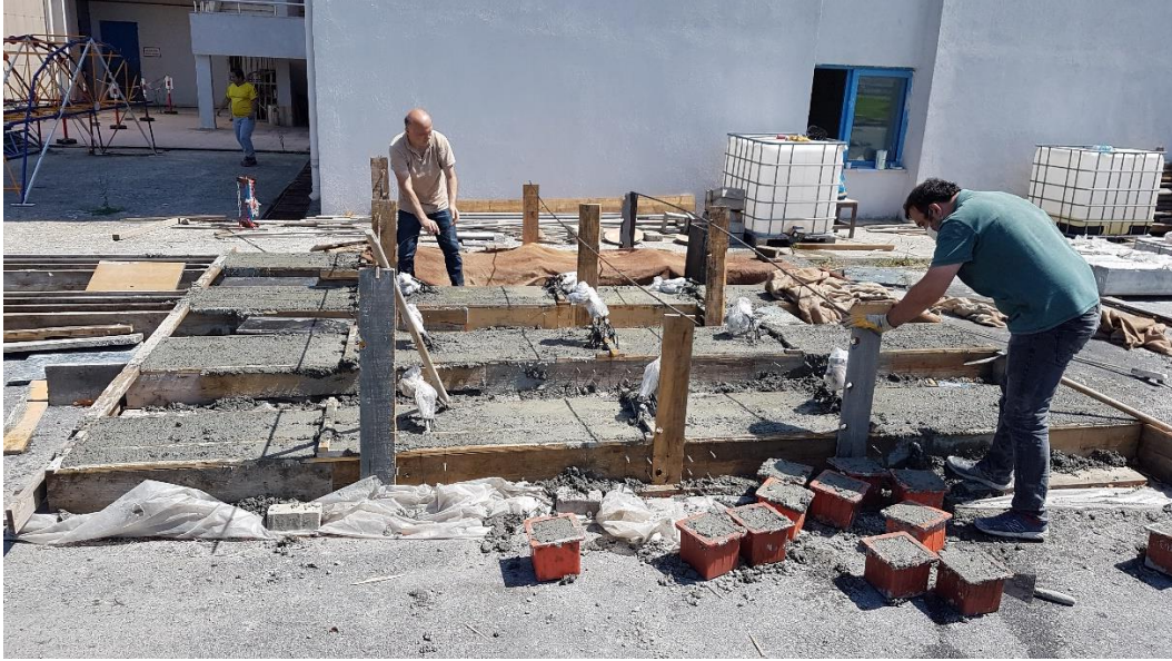
Şekil 2.5 Beton dökme işleminin tamamlanması ve beton küp numuneleri
