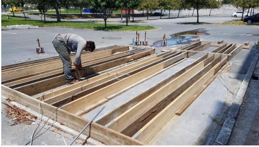
Şekil 2.1 Kiriş kalıplarının hazırlanması
