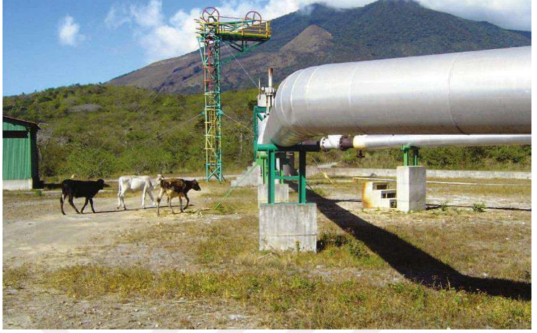
Şekil 6.3. Miravelles jeotermal enerji santrali tipik boru hattı, Costa Rica (Fotoğraf: R. DiPippo).
