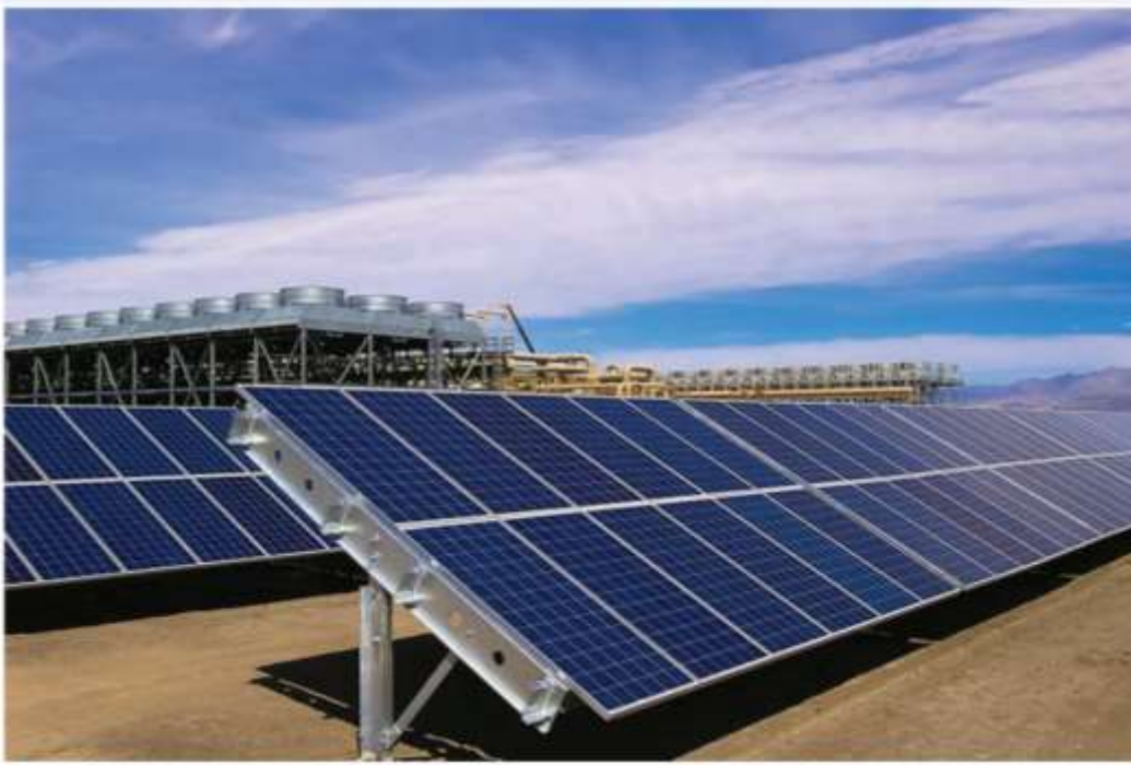
Şekil 7.4. Jeotermal ve güneş enerjisi ile hibrit uygulama örneği (Şener vd., 2022).
