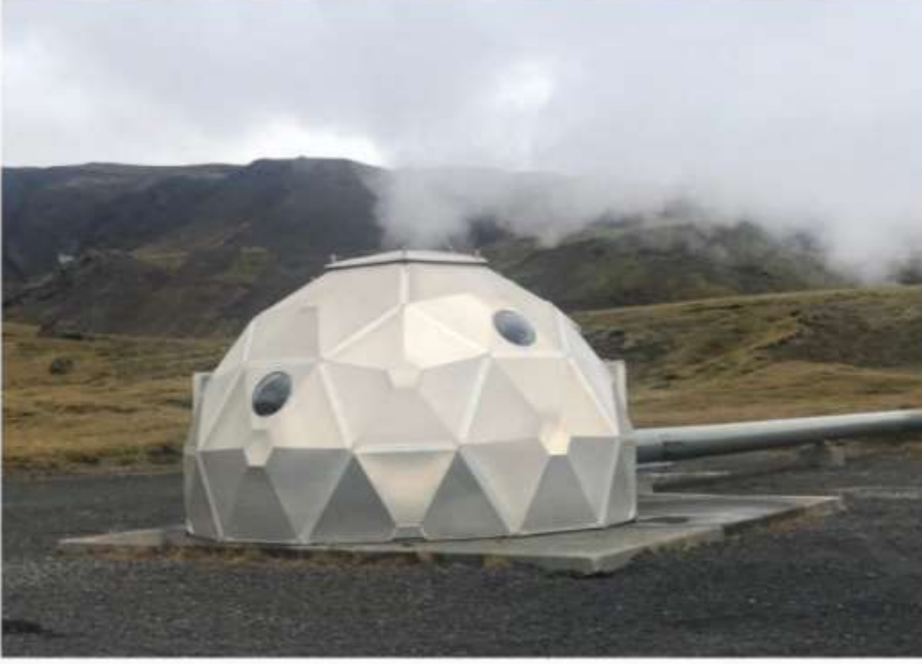
Şekil 6.2. Hellisheidi Jeotermal Sahası'ndaki ses emici içeren kuyu başı örneği (Şener vd., 2022).
