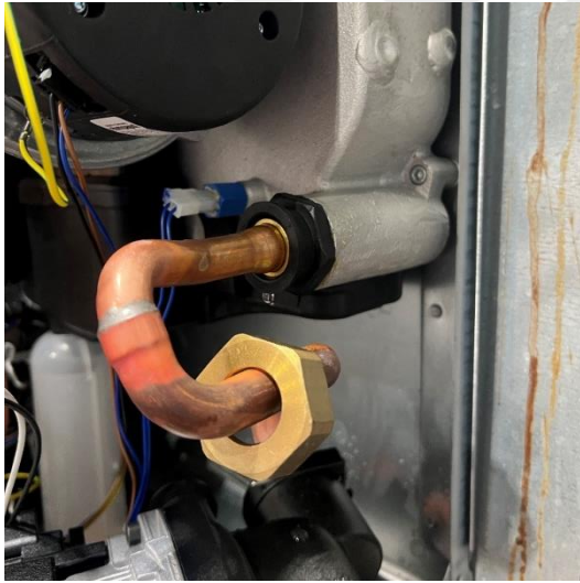
Resim 4.9. Su döngüsünün sağlandığı dönüş borusu
