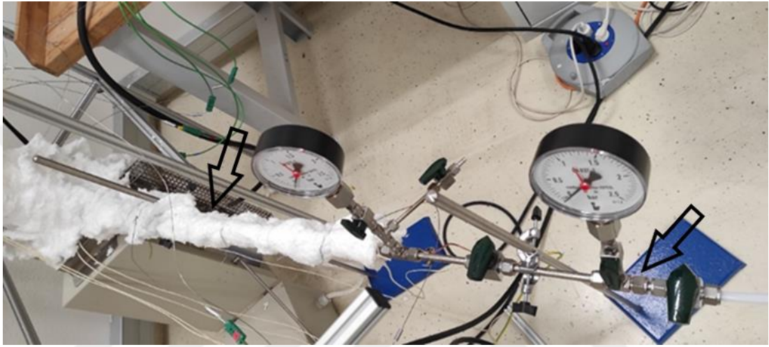
Şekil 3.10: Azot iletim boruları
