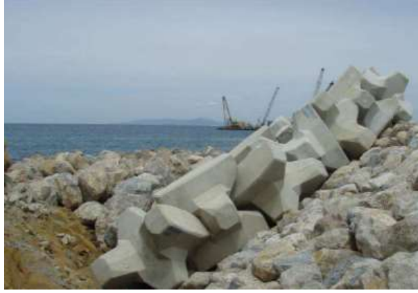
Şekil 2.13 Accropode beton blok, Giraudel (2020)
