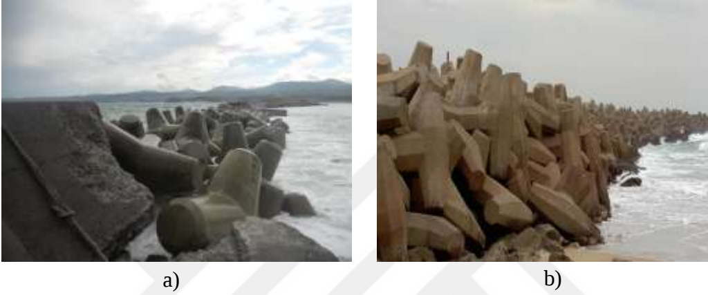
Şekil 2.12 Tetrapod ve Dolos bloklar. a) Tetrapod bloklar, b) Dolos bloklar (Esteban vd., 2016; Trotter, 2006)
