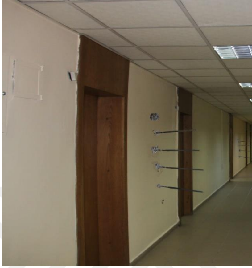
Şekil 8. Ankraj Donatısı Ekim Örnekleri (Zemin Kat Koridoru)
