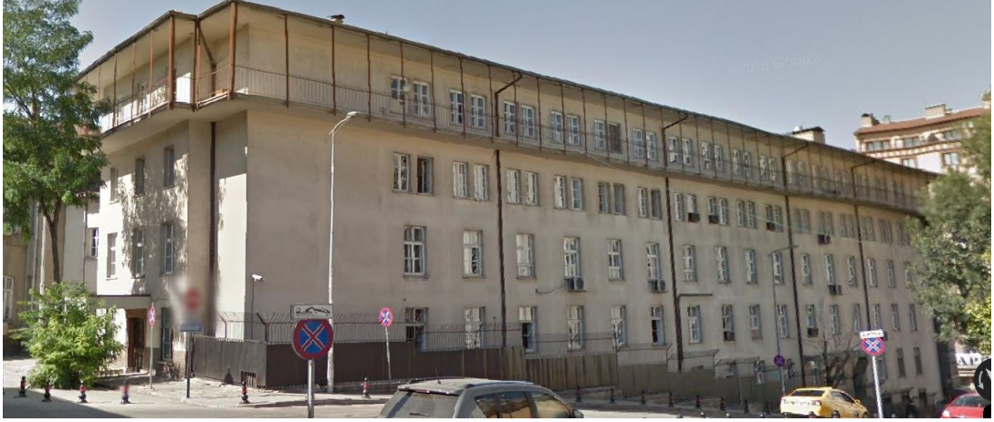
Şekil 2. C Blok Yapısı Genel Görünüm
