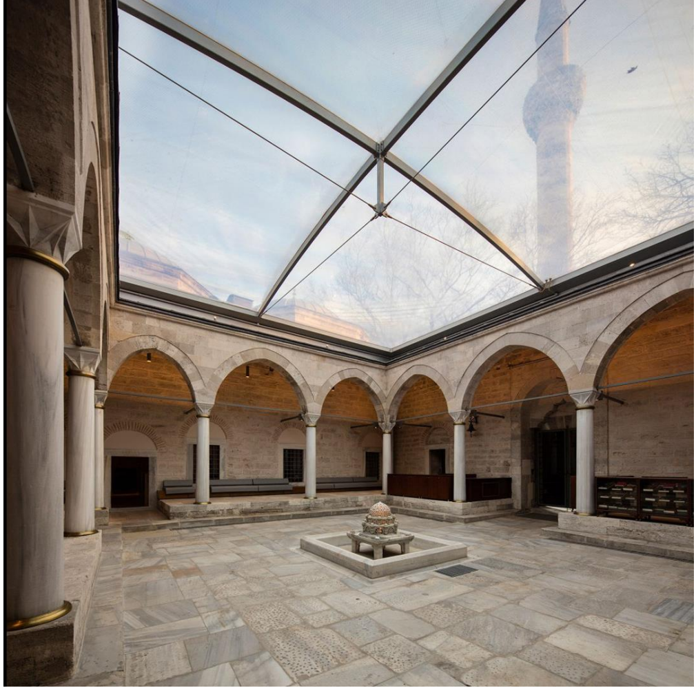
Şekil 2. 7 Avlu Da Bulunan Cam Örtü Sistemi
