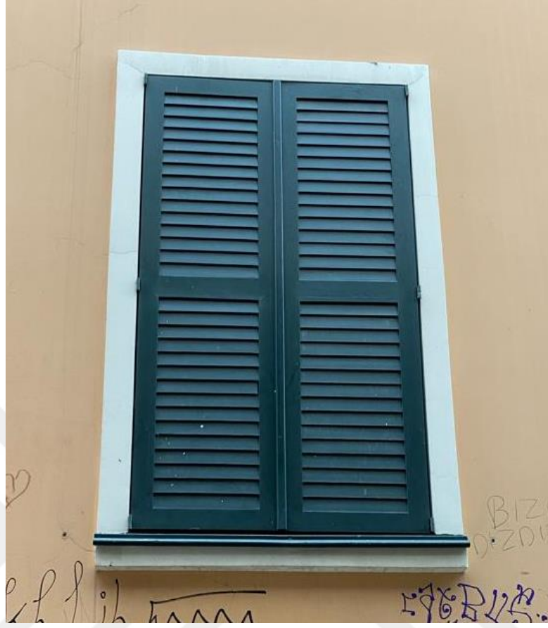
Şekil 2. 67 Narmanlı Han Müeyyet Sokak Cephesi Zemin Kat Penceresi
