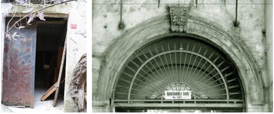
Şekil 2. 51 Restorasyon Öncesi Hanın Ahşap Kapı Detayları Ve Ferforje Detayı
