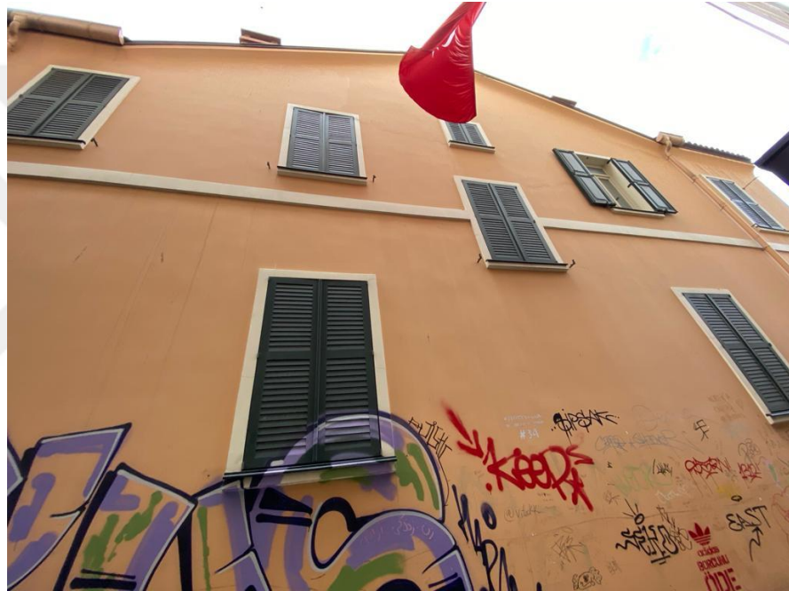
Şekil 2. 66 Narmanlı Han Müeyyet Sokak Cephesi
