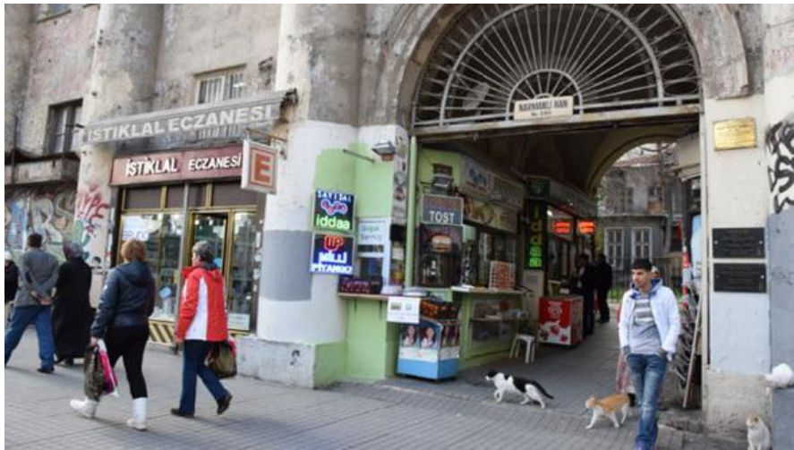
Şekil 2. 50 Restorasyon Öncesi Hanın Ön Giriş Kapısı
