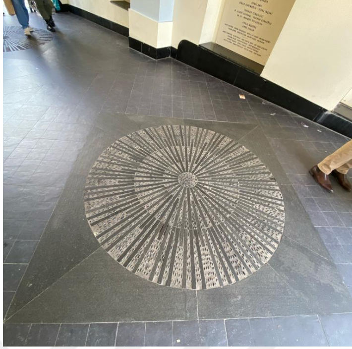
Şekil 2. 93 Narmanlı Han Restorasyon Sonrası Zemin Döşeme
