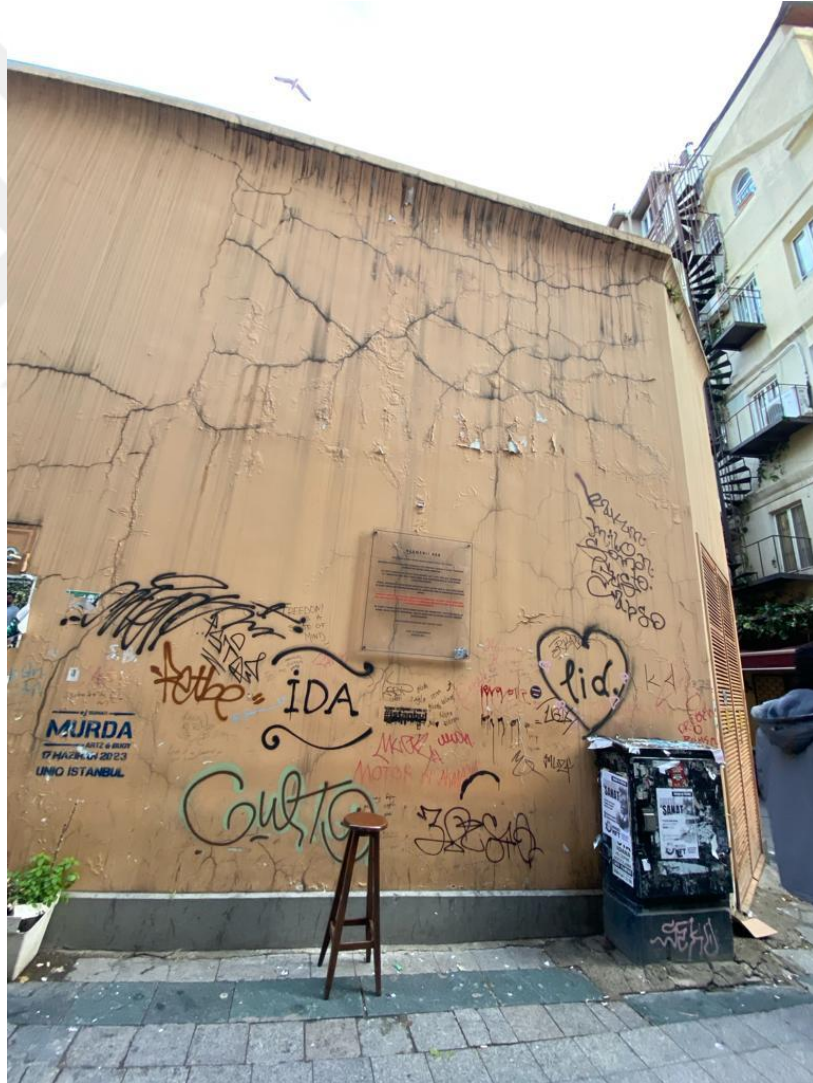
Şekil 2. 60 Narmanlı Han Arka Cephe Duvarı
