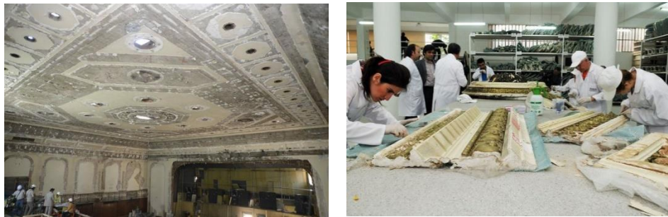
Şekil 2. 32 Emek Sinema Salonu Tavan Süslemelerinin Sökülmesi
