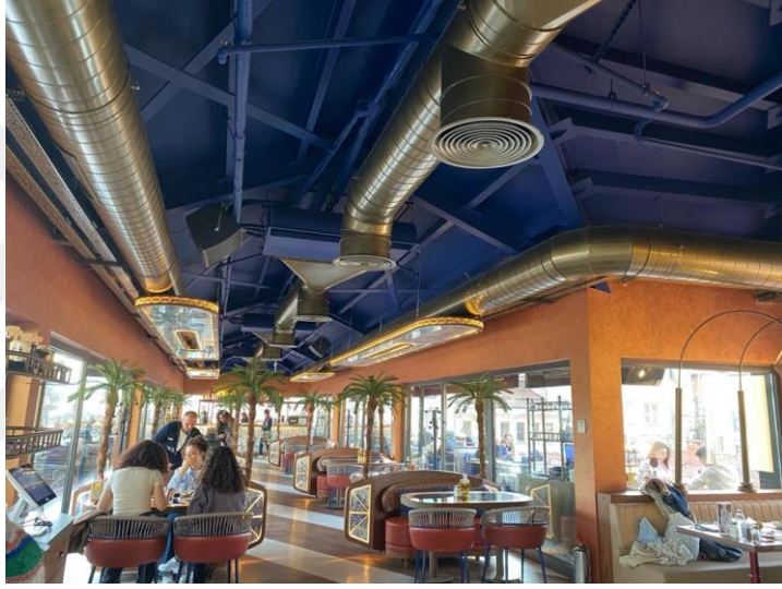
Şekil 2. 83 Mekân Çatı Görüntüsü
