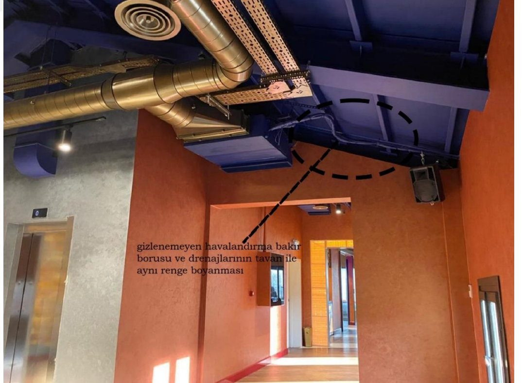
Şekil 2. 82 Havalandırma Tavan Detayı
