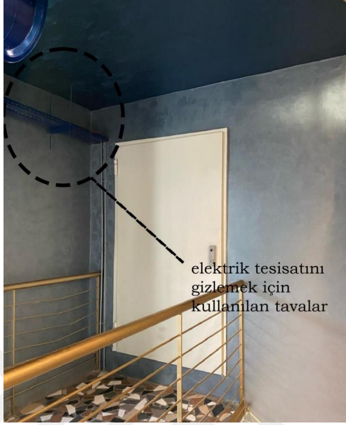
Şekil 2. 81 Elektrik Tesisat Detayı
