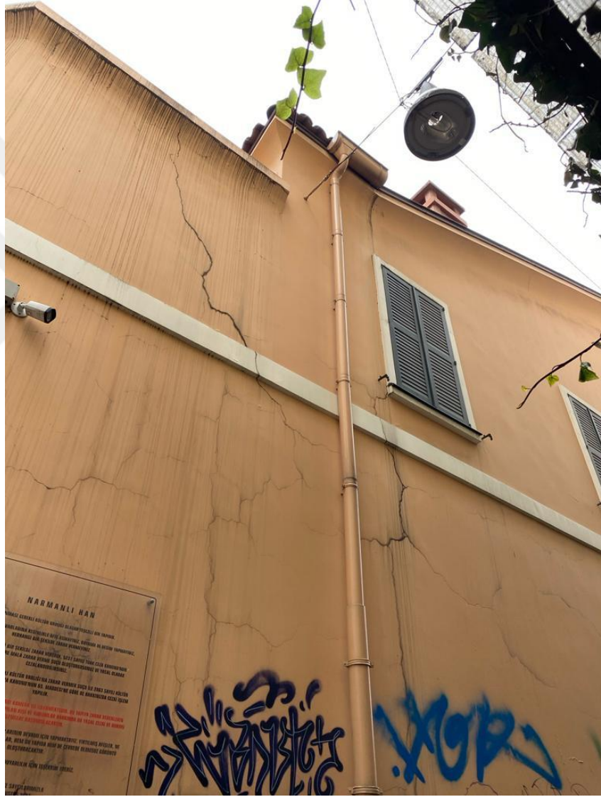
Şekil 2. 62 Narmanlı Han Restorasyon Sonrası Yan Cephesi
