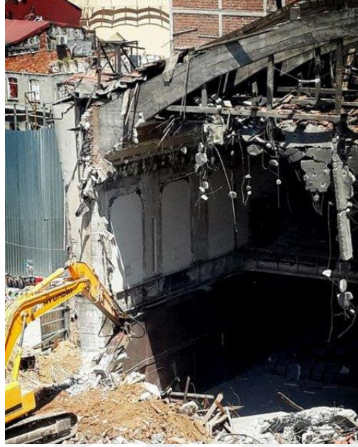
Şekil 2. 33 Emek Sinema Salonu Restorasyon Hali
