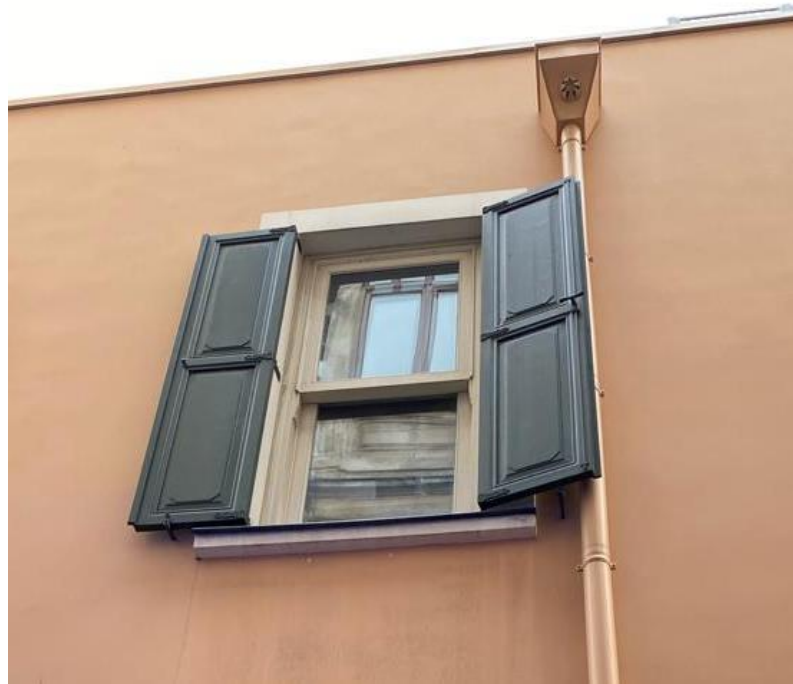
Şekil 2. 68 Narmanlı Han Müeyyet Sokak Cephesi 1. Kat Penceresi
