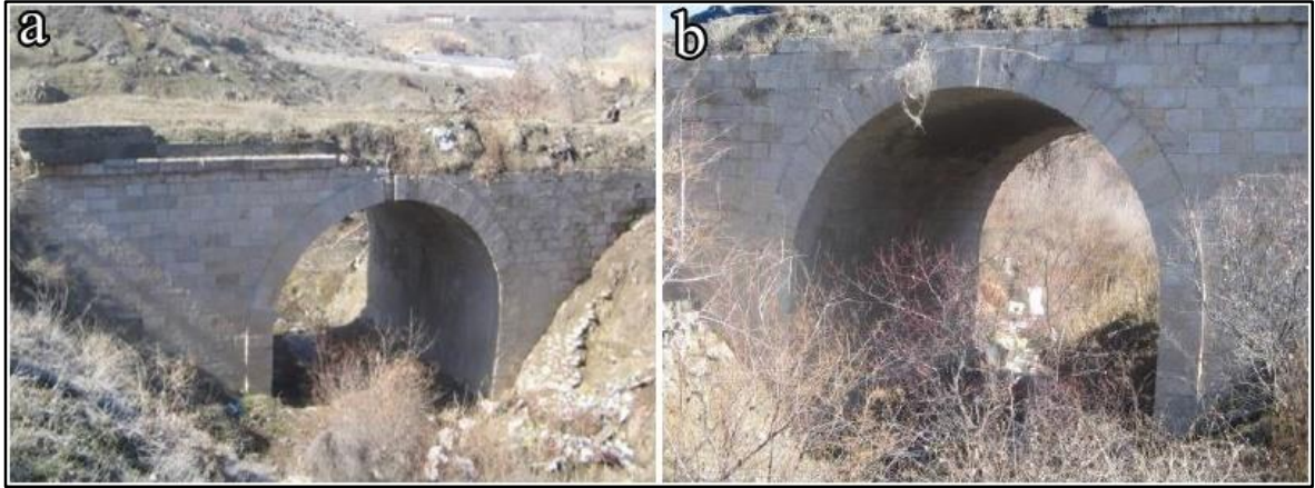
Foto 50. a) Veli Palas Köprüsü akıntıya karşı görüntüsü b) Veli Palas Köprüsü akıntı yönünde görüntüsü (Özmen & Sayın, 2023:26)
