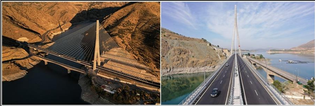
Foto 11. Yeni Kömürhan Köprüsü (Gülsan Holding, 2023. Erişim tarihi 06.04.2023
