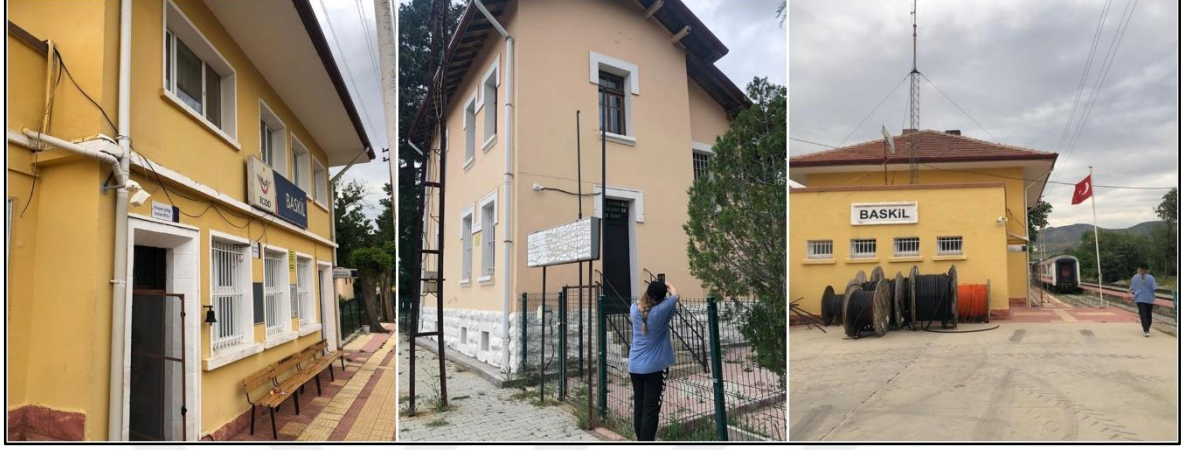
Foto 52. Şefkat İstasyon Binası
