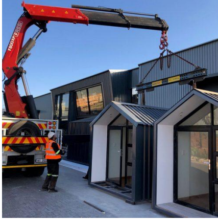
Şekil 3.2 Vinç kullanımı ile taşınan tiny house örneği
