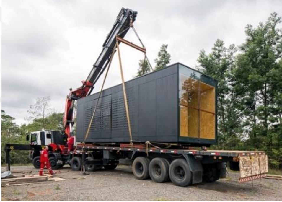
Şekil 3.3 Tır kullanımı ile taşınan tiny house örneği
