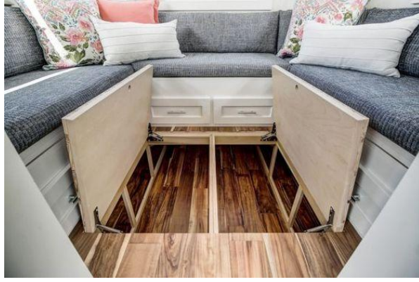
Şekil 3.33 Tiny house tasarımında parke zeminde gizli depolama alanları örneği
