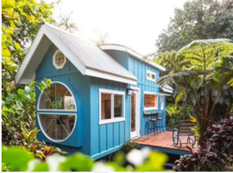
Şekil 4.1 Oasis Tiny house, Keaau (Kaynak: teenyabode.com)
