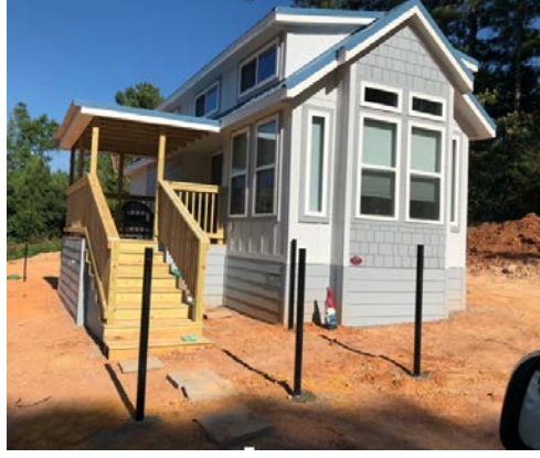
Şekil 3.4 Zemine sabit tiny house örneği
