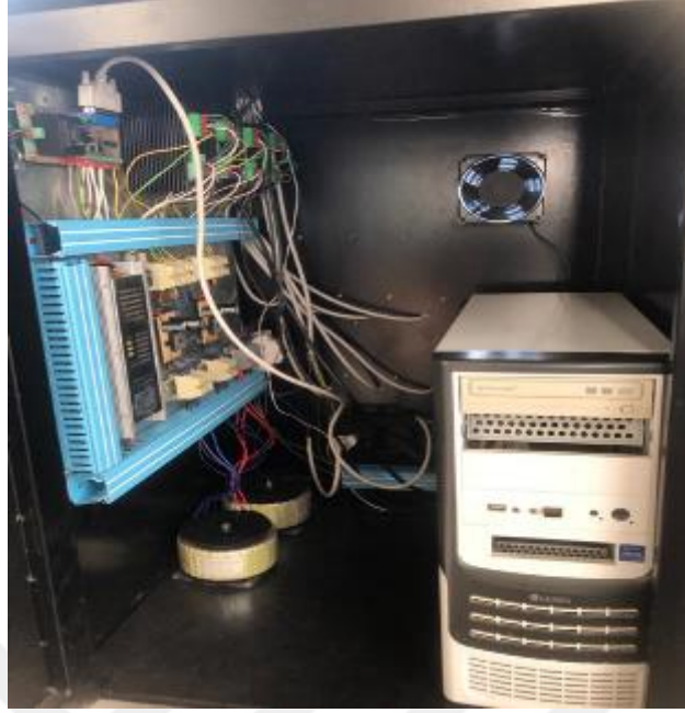
Şekil 3.35 Kontrol ünitesinin imalatı yapılan panoya montajı
