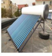
Güneş enerjili su ısıtma sistemi
