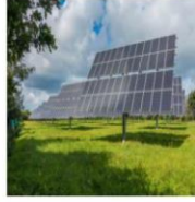
Güneş enerjili elektrik paneli
