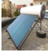
Güneş enerjili su ısıtma sistemi
