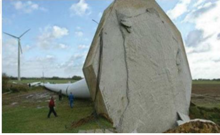
Şekil 3.9. Devrilmiş bir rüzgar türbininin yüzeysel temeli [25]
