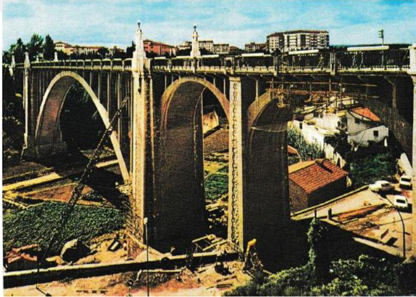
Şekil 3.14. İspanya'nın Teruel şehrinde yapılan viyadükte mikro kazık uygulaması [15]
