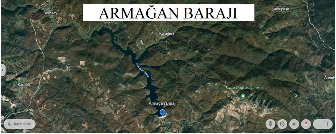
Şekil 3.3. Armağan Barajının coğrafi koordinat sisteminde bulunduğu yeri (07/12/2023 Tarihli Google Earth Uydu Görüntüsü)
