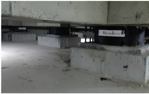
Şekil 2.10. İstanbul Aykent Loft Sismik İzolatör Detayları
