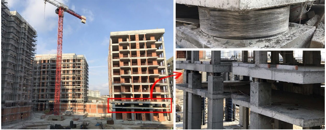
Şekil 2.15. İstanbul Maveria Comfort Sismik İzolatör Detayları
