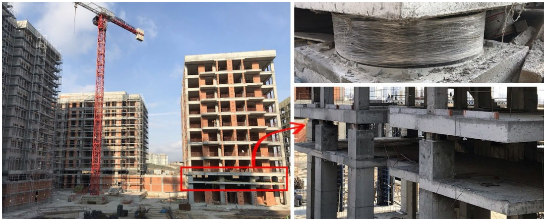
Şekil 1.19. İstanbul Maveria Comfort Sismik İzolatör Detayları
