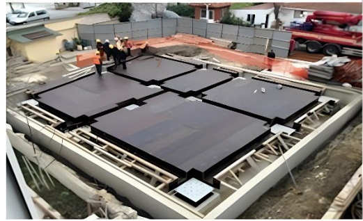
Şekil 2.10. İstanbul Aykent Loft Sismik İzolatör Detayları
