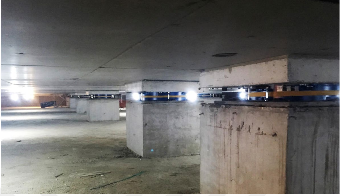
Şekil 1.17. İnşaatı Tamamlanmış Bir İzolatörlü Yapının Deprem İzolatörlü Katından Görünüşü Örnek-1
