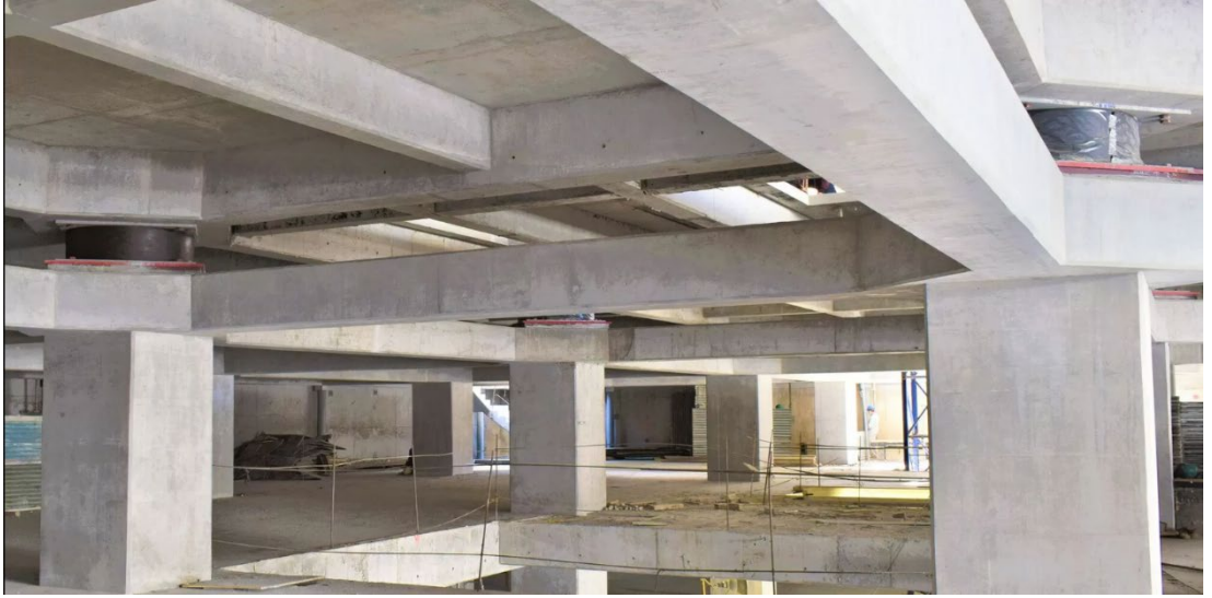
Şekil 1.18. İnşaatı Tamamlanmış Bir İzolatörlü Yapının Deprem İzolatörlü Katından Görünüşü Örnek-2
