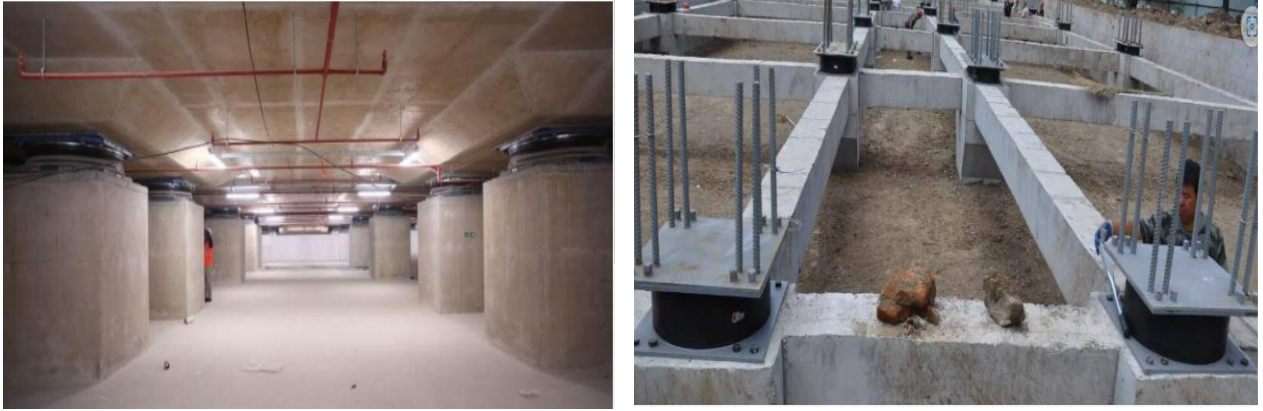
Şekil 2.24: Bina temeli için kurşun kauçuk mesnet (Taban izolasyon) [31].
