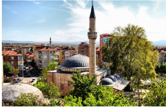
Şekil 3.10. Yığma taşıyıcı sistemli minare
