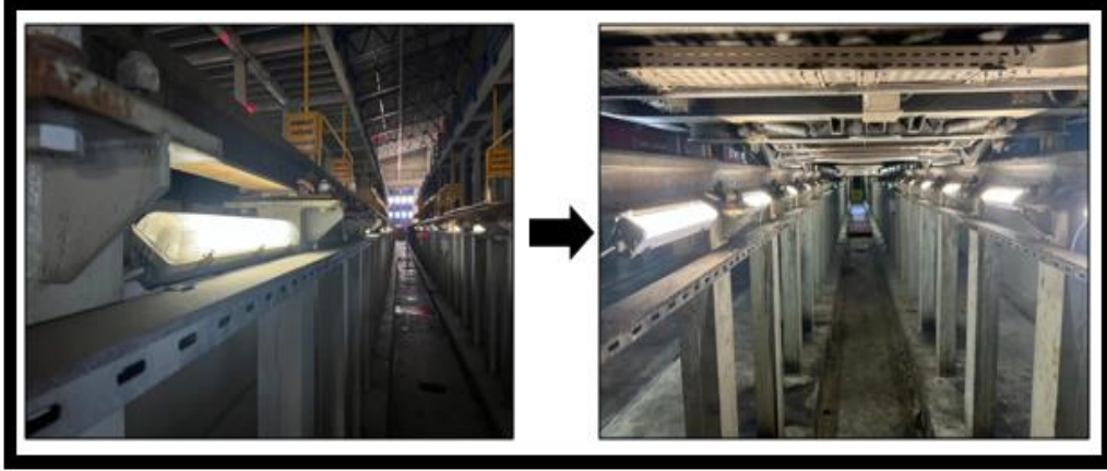
Şekil 4.27:Yol Alt Kanal Aydınlatma Çalışması
