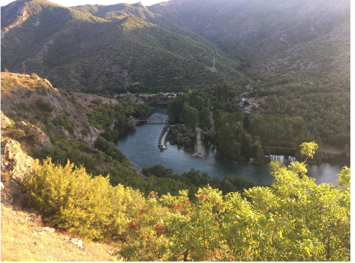
Şekil 35. Ataköy Barajı (Bakış Yönü: Güneybatı) (Duman, 2022).
