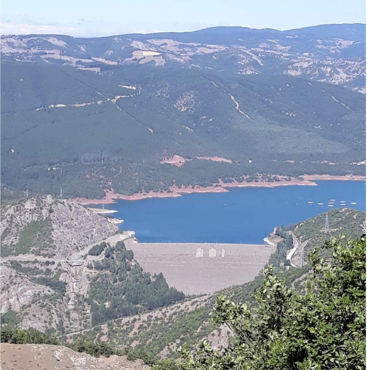
Şekil 34. Almus Barajı (Bakış Yönü: Kuzeydoğu).
