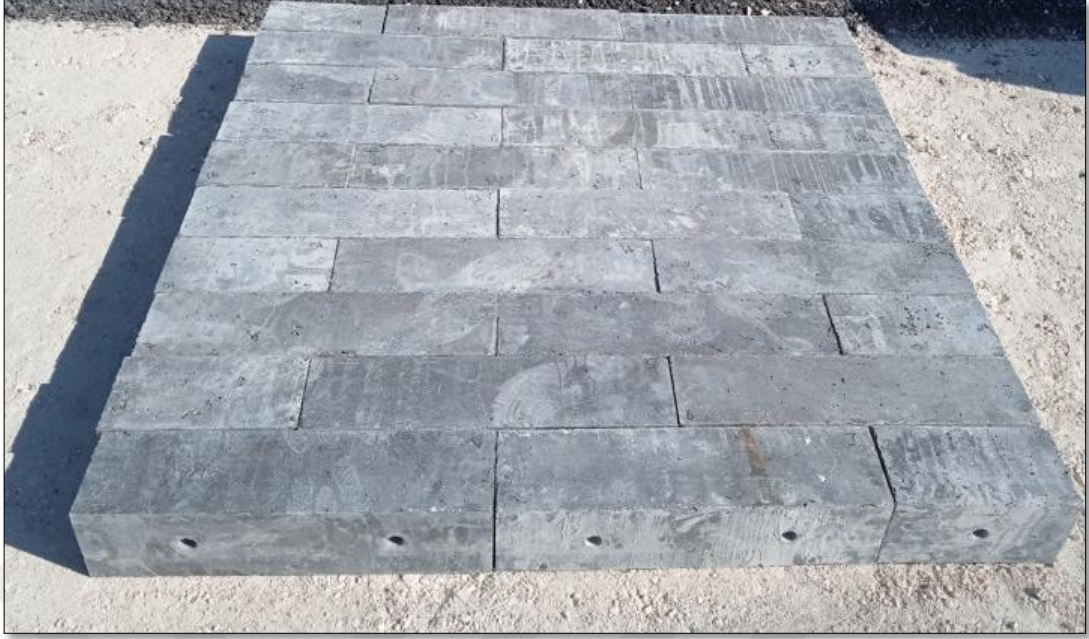
Şekil 3.4. Modüler beton yol (MBY) kaplaması
