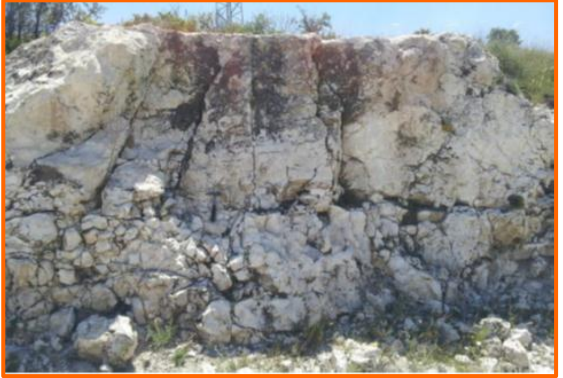
Şekil 8.4 Kırık ve çatlaklı yapıdaki kireçtaşlarından bir görünüm (Yenibosna'dan çekilmiştir)
