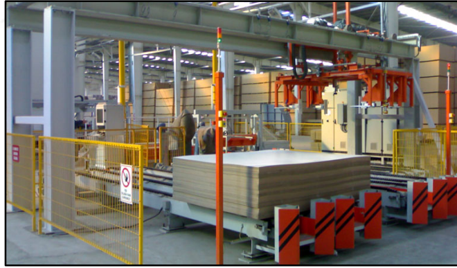
Şekil 16: Ebatlama ünitesi genel görünüşü (URL-16, 2013).
