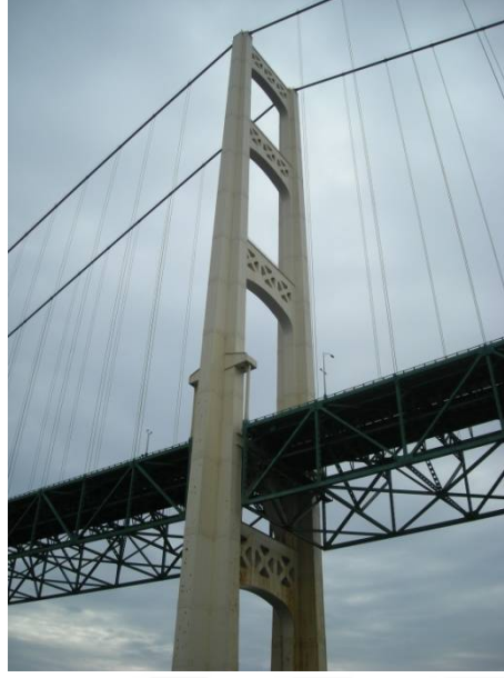
Şekil 2.9 Mackinac Straits köprüsünün tabliyesi [37]
