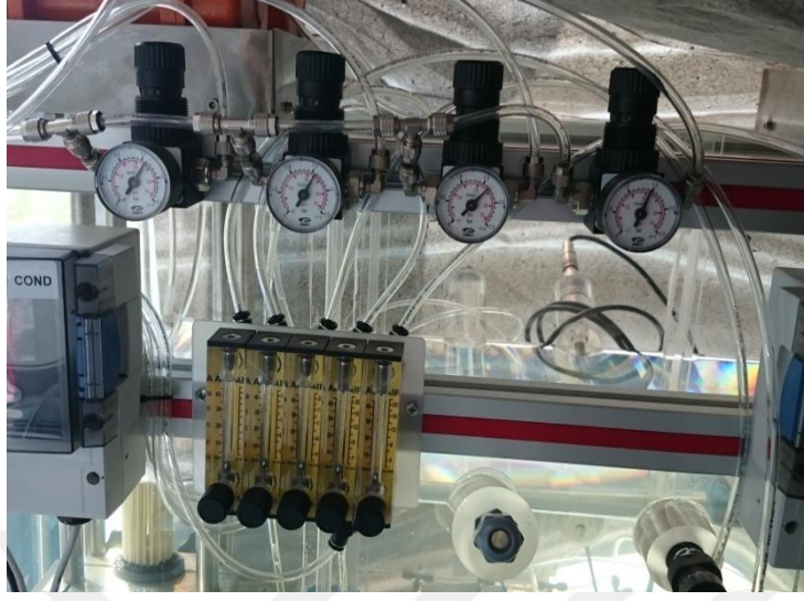
Şekil 3.4 : Havalandırma vanalarının görünümü.
