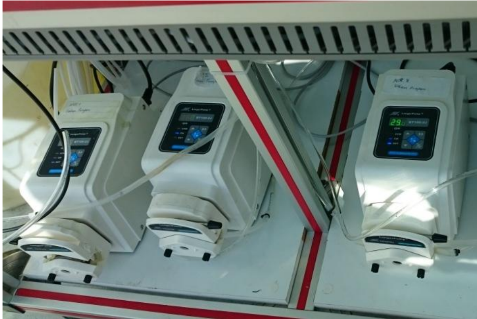
Şekil 3.12 : Vakum pompalarının görünümü.
