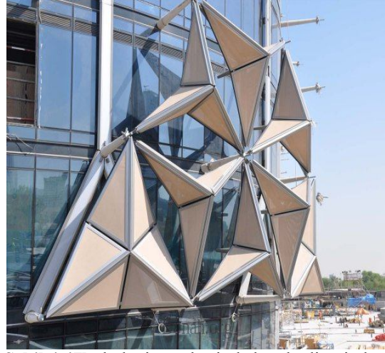
Şekil 4.47b. kulenin cephesinde hareketli üniteler
