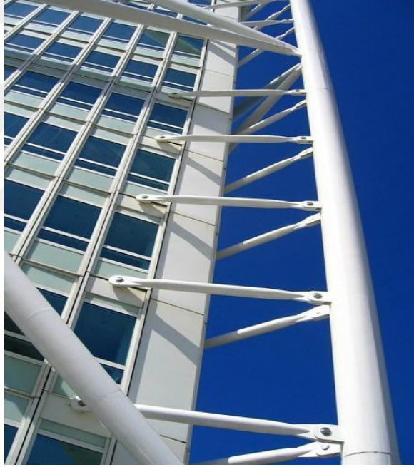
Şekil 5.42. Bina destek olmak için çelik çerçevesi(Lieb & Heusler, 2006)
