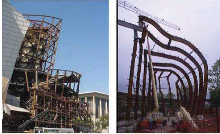
Şekil 3.18b. Metal profillerden yapısal gövde(Khalil, 2001)
