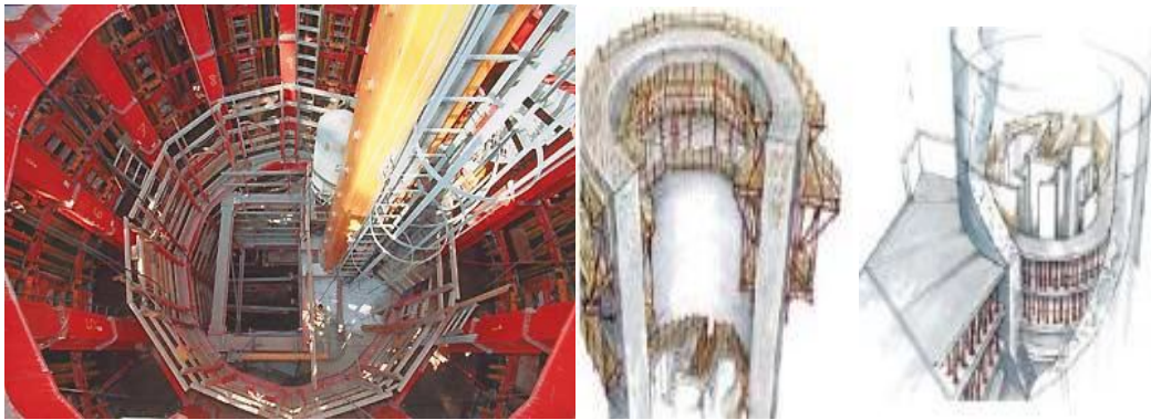
Şekil 5.41. Kabuli şeklinde yatay gövdelerin birbirine bağlandığı ana merkezi silindir, asansörleri, hizmetler ve teknolojik sistemleri ihtiva etmekte
