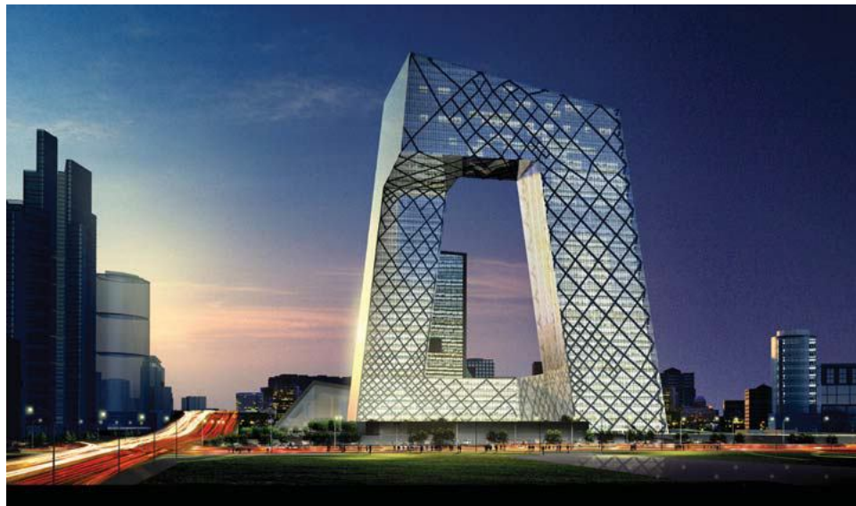
Şekil 5.34. Çin merkezi televizyon binası kulesi ,Genel Görünüm
