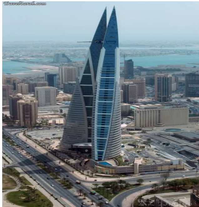
Şekil 4.27. Bahreyn uluslararası ticaret merkezi binası
