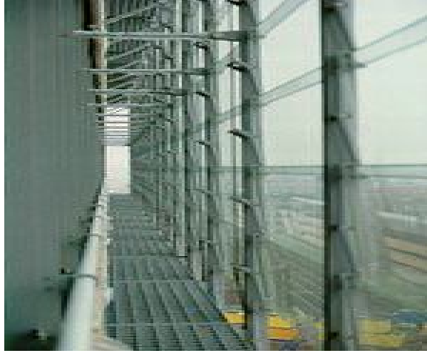
Şekil 4.49c. Binanın içerisinden görünüm, intersitisyel boşluğu(Compagno, 1995).
