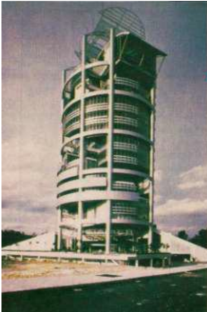
b. Alüminyum levhalar kullanılmaktadır
