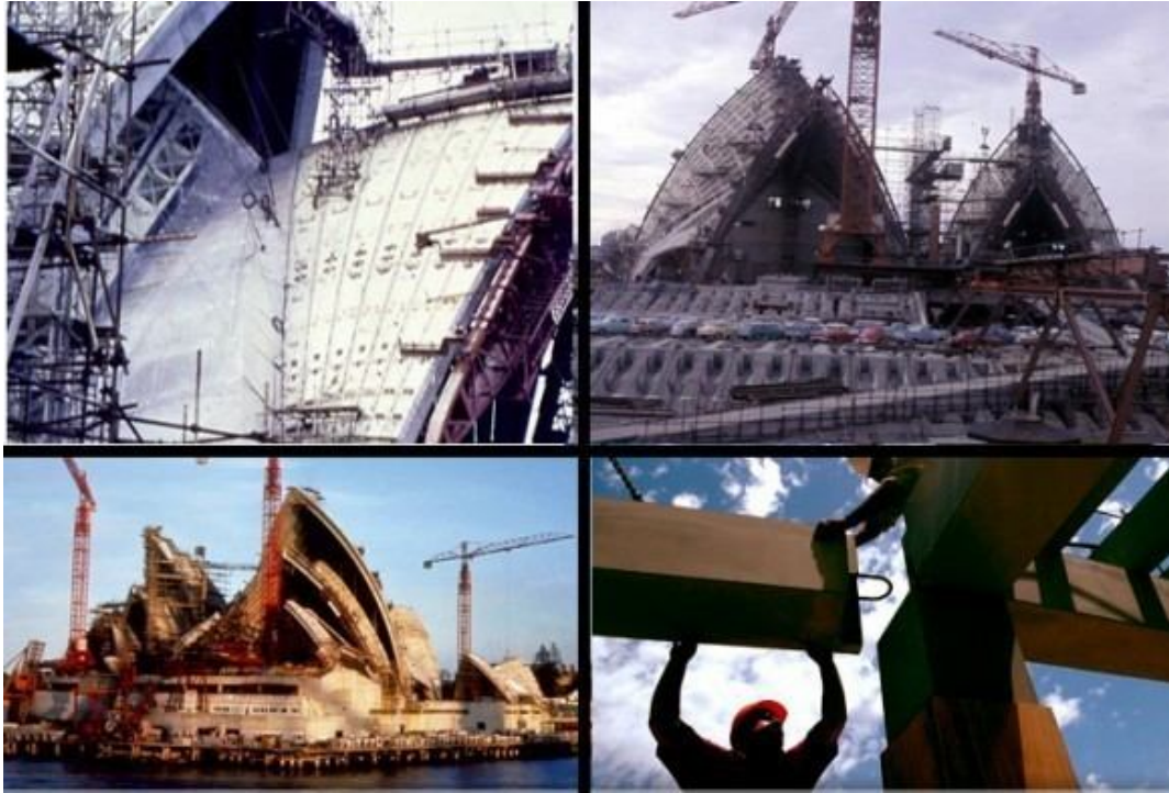
Şekil 3.11b. Sydney’deki opera binası projesi (İnşaat aşamasında) (Khalil, 2001)
