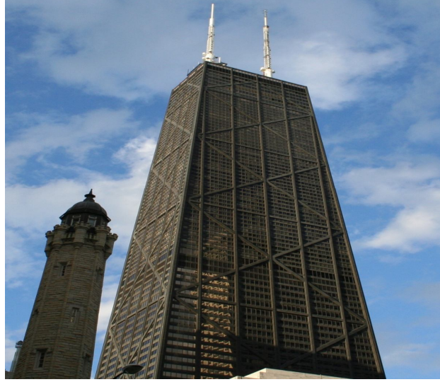
Şekil 4.73a. Chicago'daki Jhon Hankok binası
