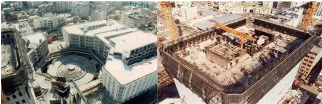
İnşaat aşamasında Şekil 5.57. İnşaat sistemi
