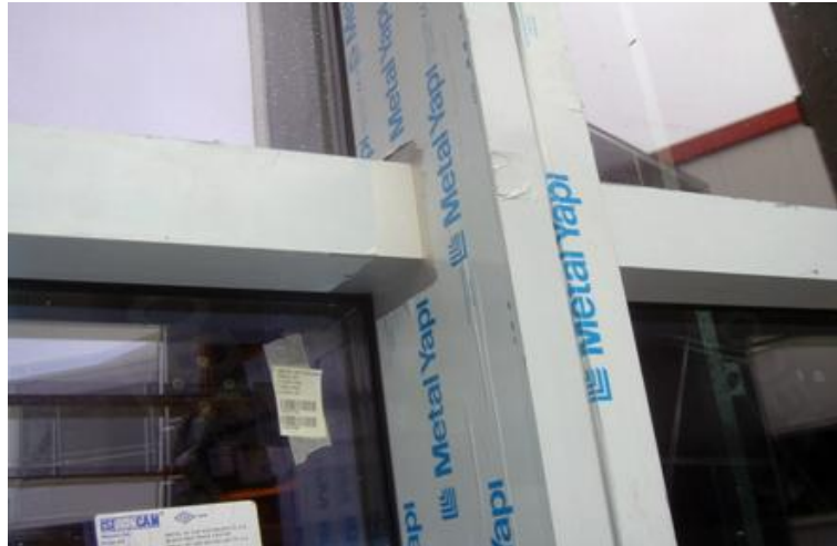
Şekil 3.7 : Panel birleşim noktası detayı.
