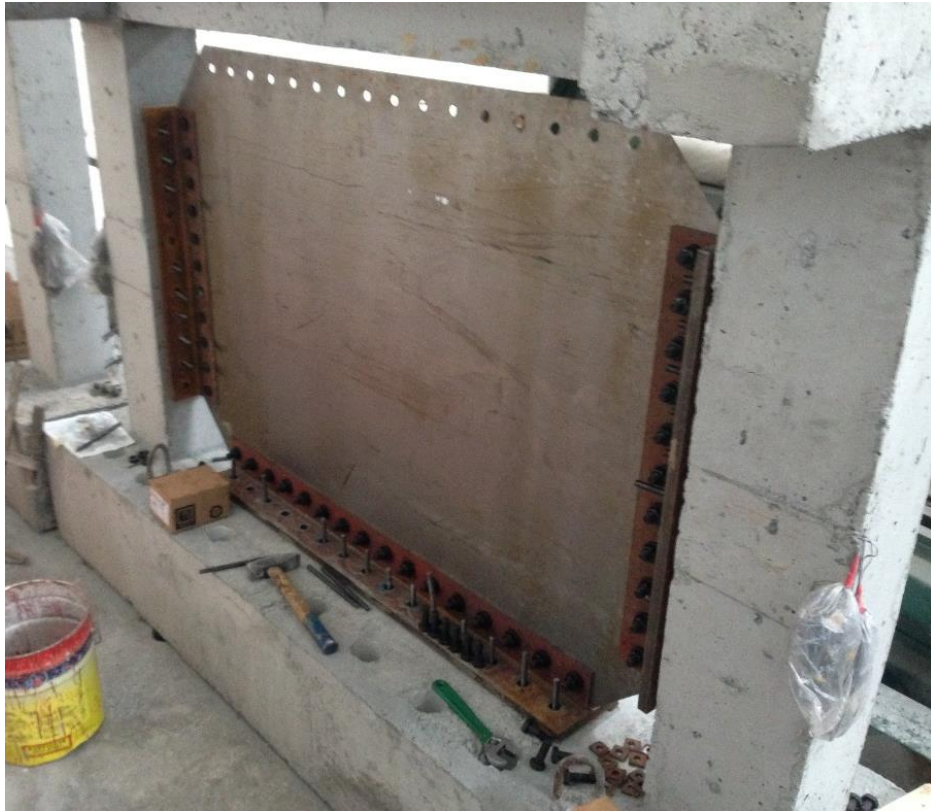
Şekil 3.6 : Çelik elemanların betonarme çerçeveye montajı.
