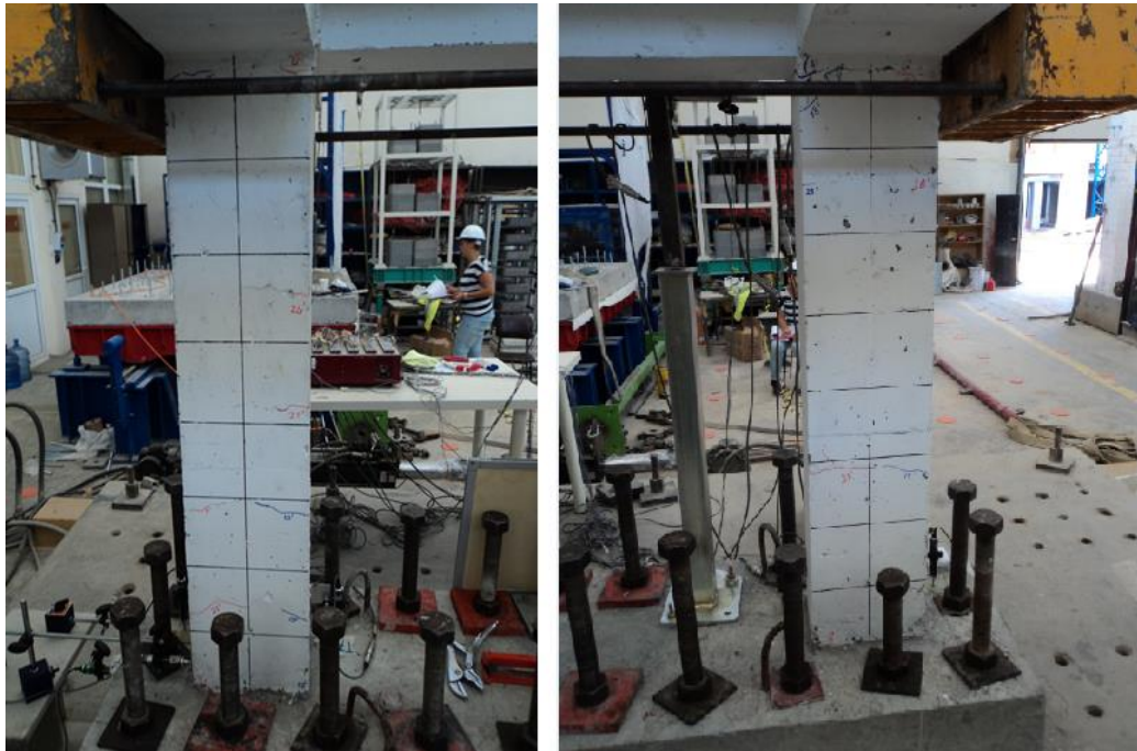
Şekil 6.4: Numunede oluşan yatay ve diyagonal çatlaklar.
