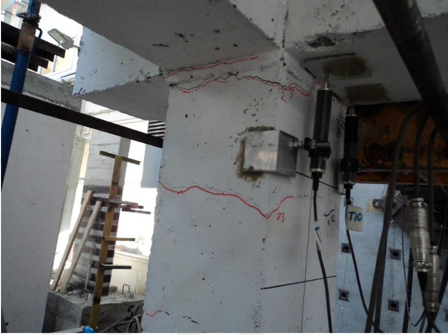
Şekil 6.5: 15. adım sonrası numunede oluşan derin çatlaklar.
