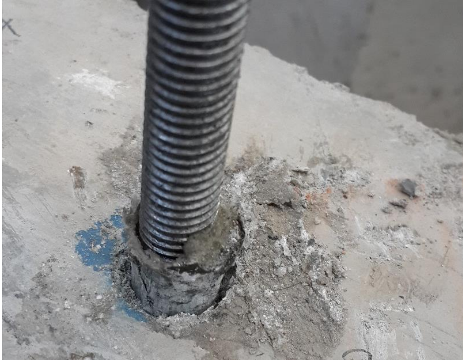
Şekil 5.17: Ankraj bulonu sıyrılma testi sonucu meydana gelen güç tükenmesi.
