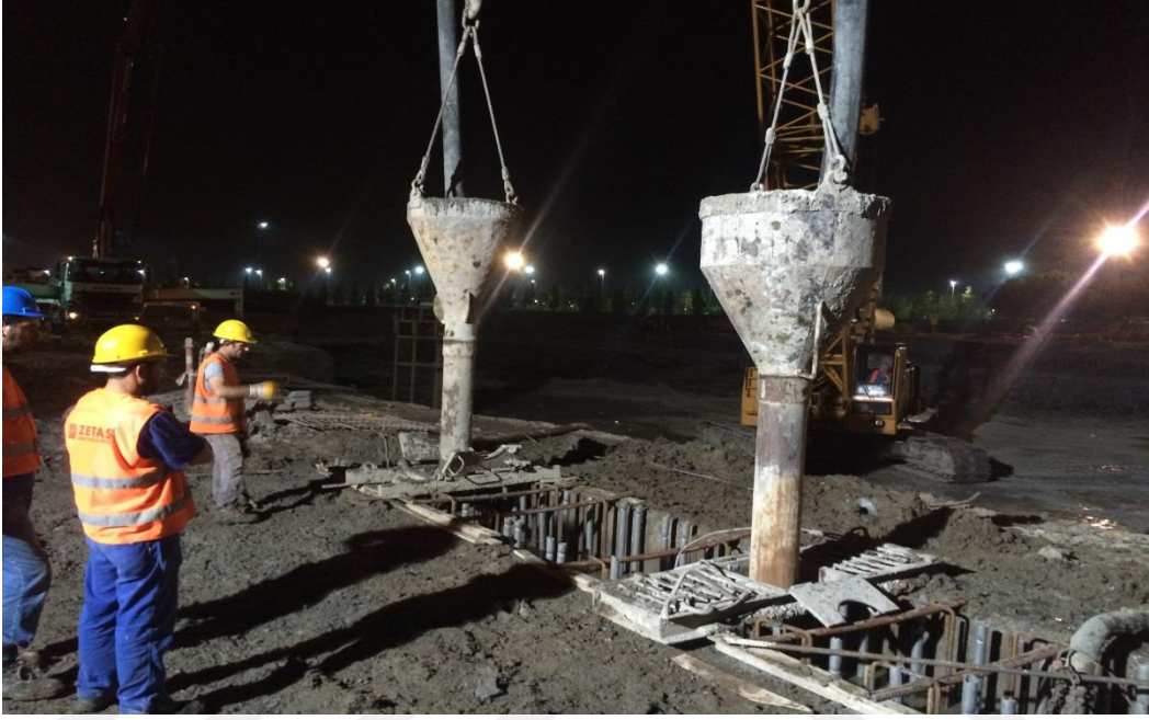
Şekil 5.4 Kazı çukurunun betonlanması
