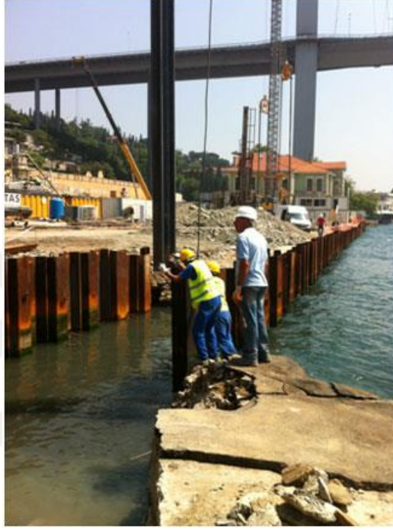
Şekil 5.5 Palplanş perdelerin yerleştirilmesi
