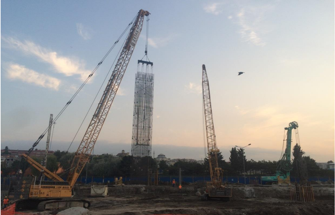
Şekil 5.3 Hazırlanan donatının vinç yardımıyla kazı çukuruna doğru taşınması
