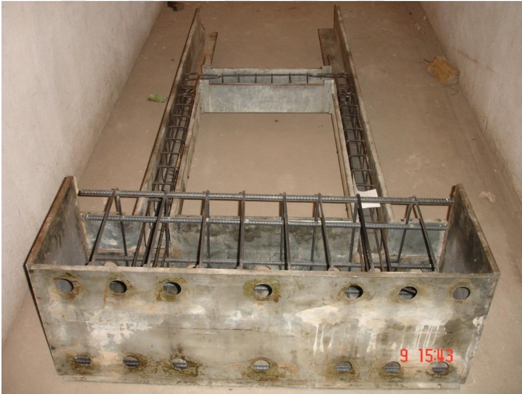
Şekil 3.7. Çerçeve kalıbı ve donatıları
