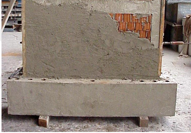
Şekil 3.11. Sıvalı duvar yüzeyi
