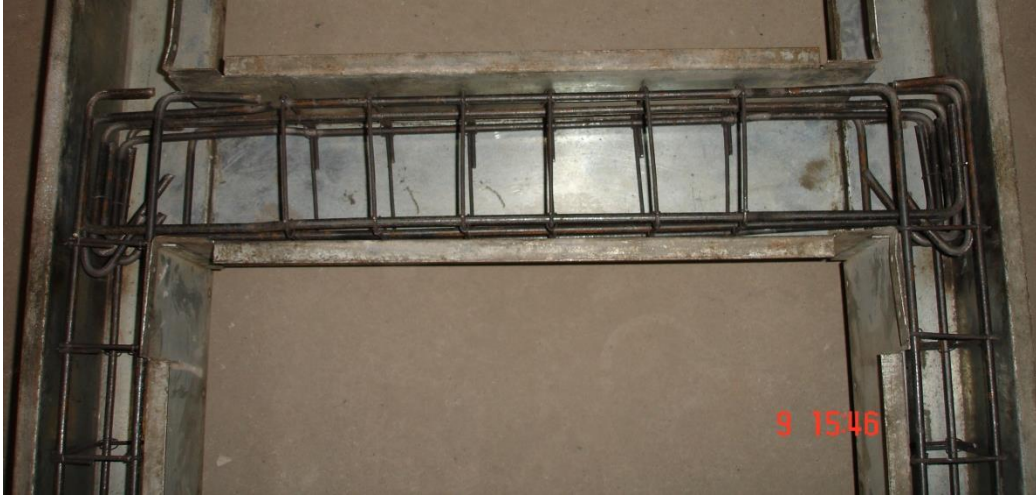
Şekil 3.6. Kiriş ve kolon-kiriş birleşim bölgeleri
