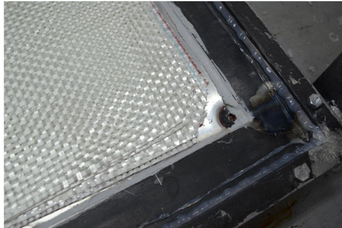
Şekil 6.2: Kalıplar arası sızdırmazlık işlemi.
