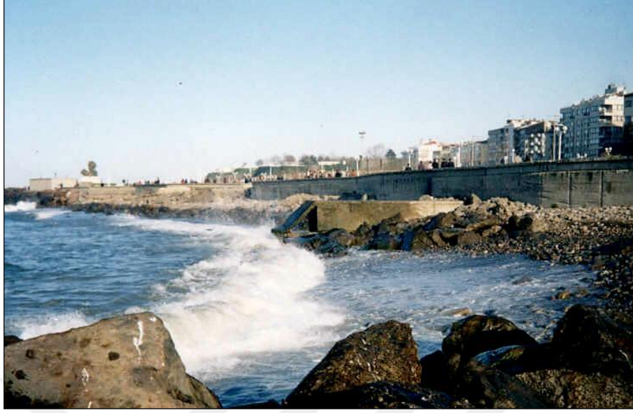
Şekil 2.10: Deniz kıyısına evsel atıksuyun yüzeysel kısa deşarjı (Karadeniz, Trabzon) (Nemlioğlu, 2003).
