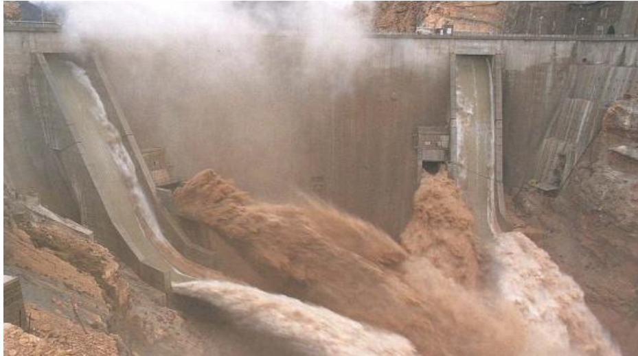
Şekil 3.19: Sediment yüklü akımın dipsavaklardan mansaba aktarılması (DSİ Arşiv, 2005).
