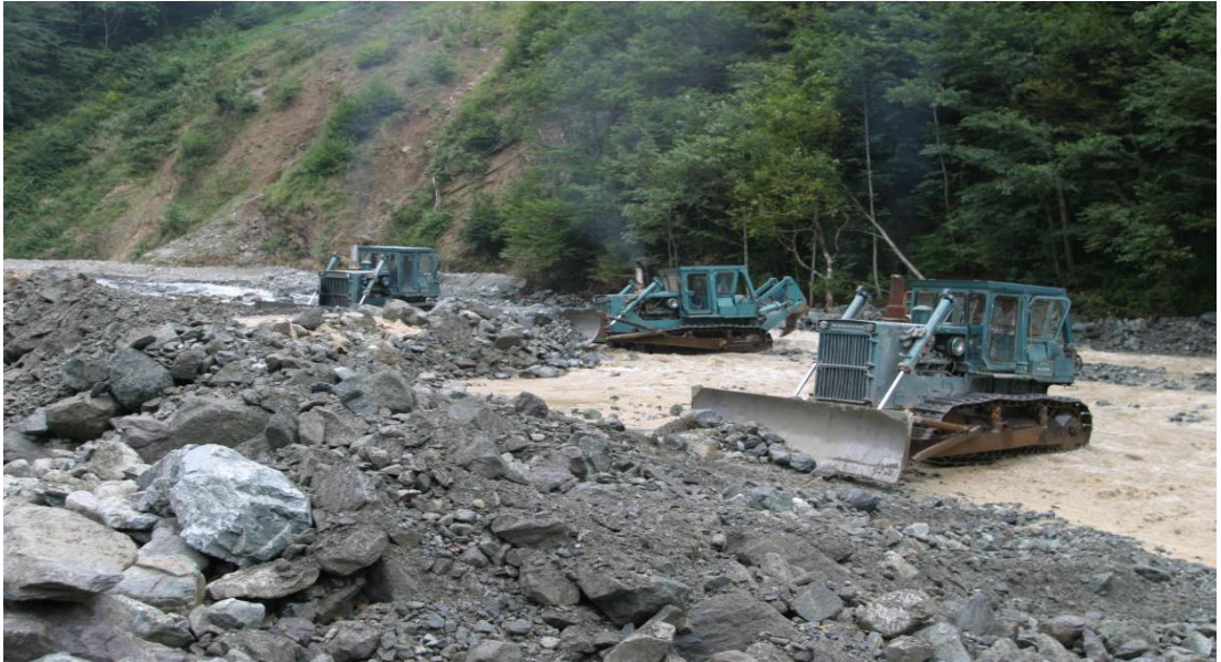
  ekil 3.18: DSİ tarafından yapılan sediment uzakla  tırma   alı  ması (Odaba  ı, 2011).
