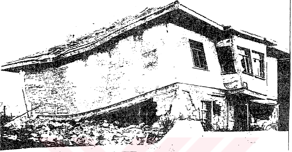
Şekil D.11 1970 Gediz depremi, İğdiş Köyü, zemin katı kargir üst katı bağdadi Yapı ( Gediz depremi sempozyumu, 1970 )
