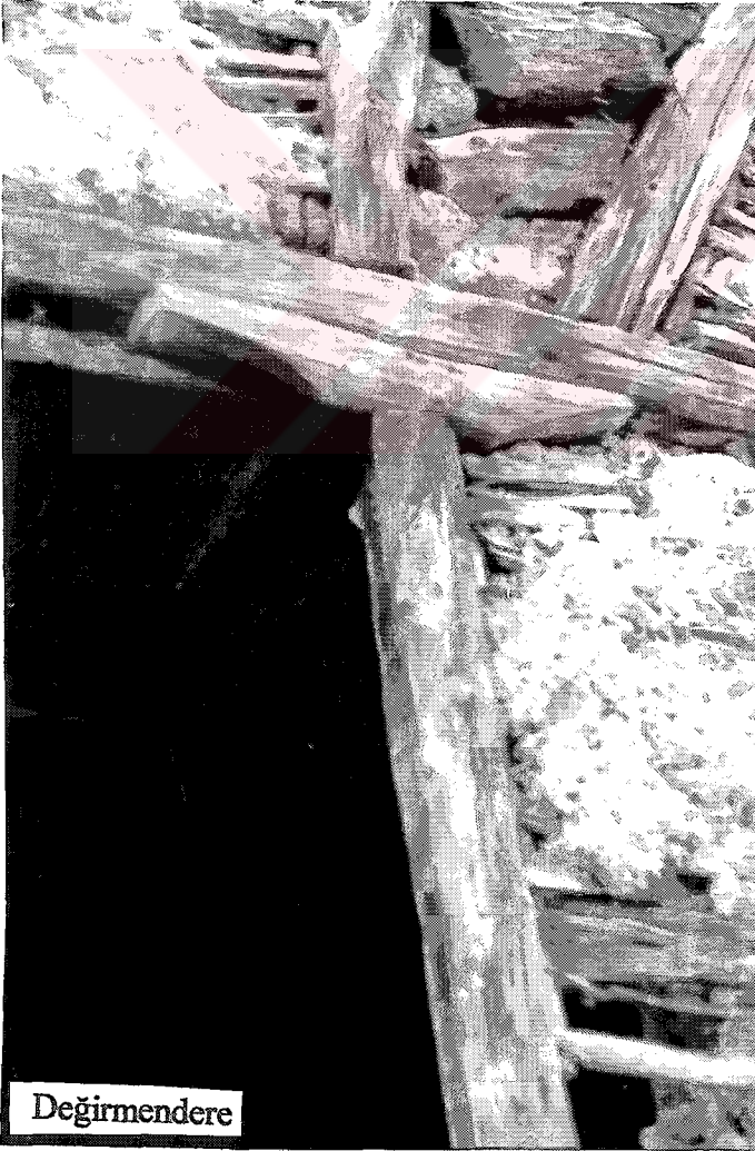
Şekil E.84 Üst kat tabanının bir başlık aracılığı ile dikmeye oturtulmasına örnek
