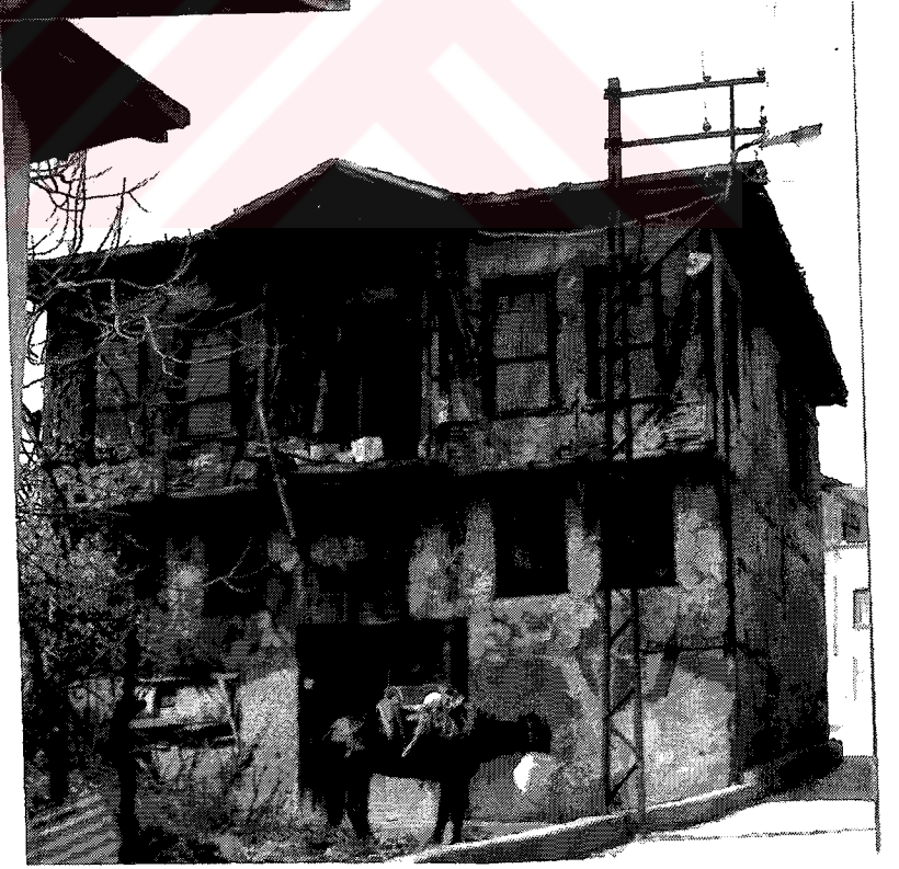
Şekil E.27 Bölgede taş dolgulu ahşap iskeletli yapı örneği
