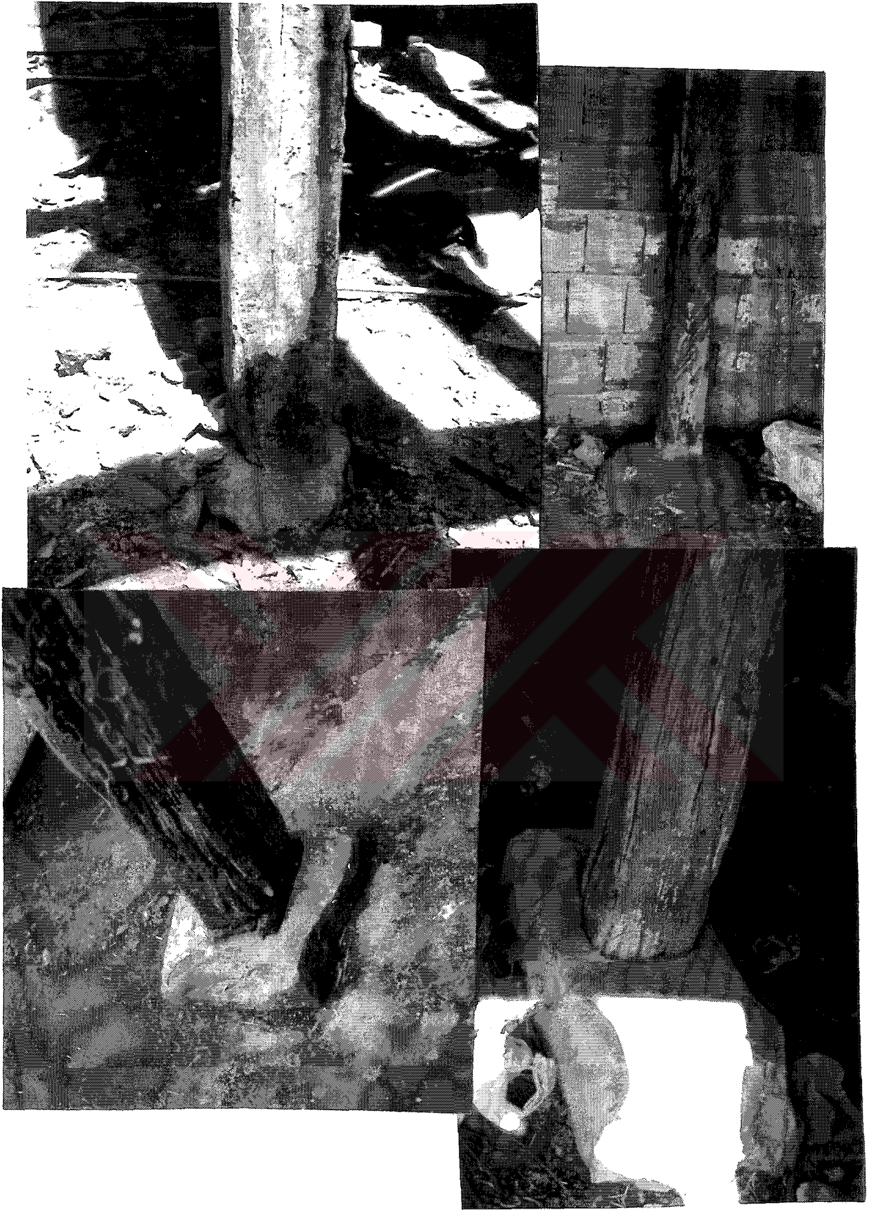
Şekil E.66 Bölgede iç mekanlarda ( zemin katlarda ) bulunan taşıyıcı dikmelerin oturduğu kaide taşları
