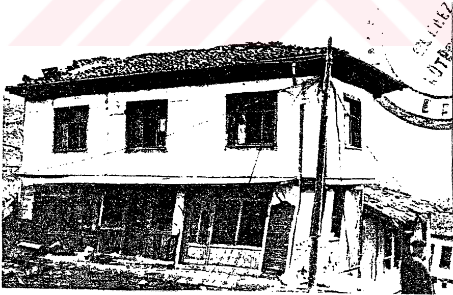
Şekil D.46 1970Gediz depremi, yumuşak kat nedeniyle yapının hasar alması (Yarar vd., 1970: 43 )
