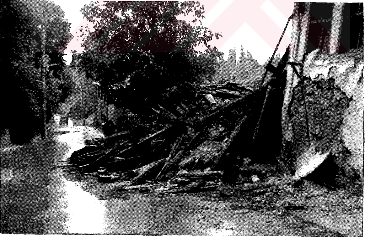
Şekil D.77 Gölcük Yukarı Değirmendere, depremde yıkılan bir ahşap iskeletli yapı ( Değirmendere Belediyesi arşivi )
