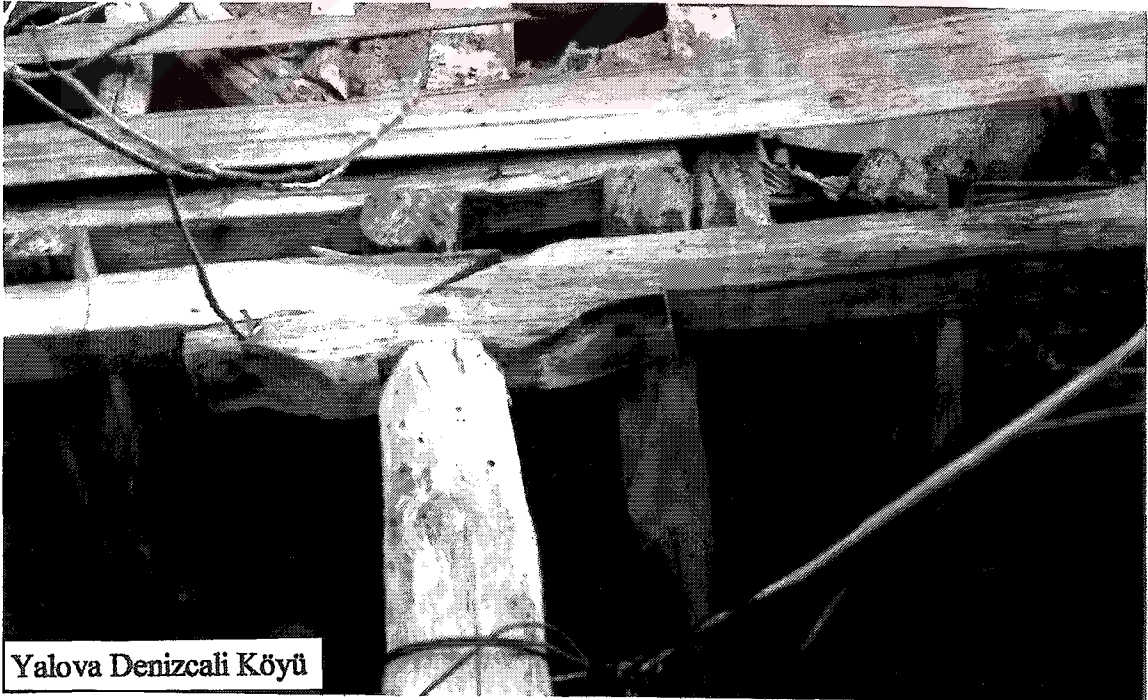
řekil E.107 Blgedeki bazı yapılarda tabanlarda ek yapılmasına rnek
