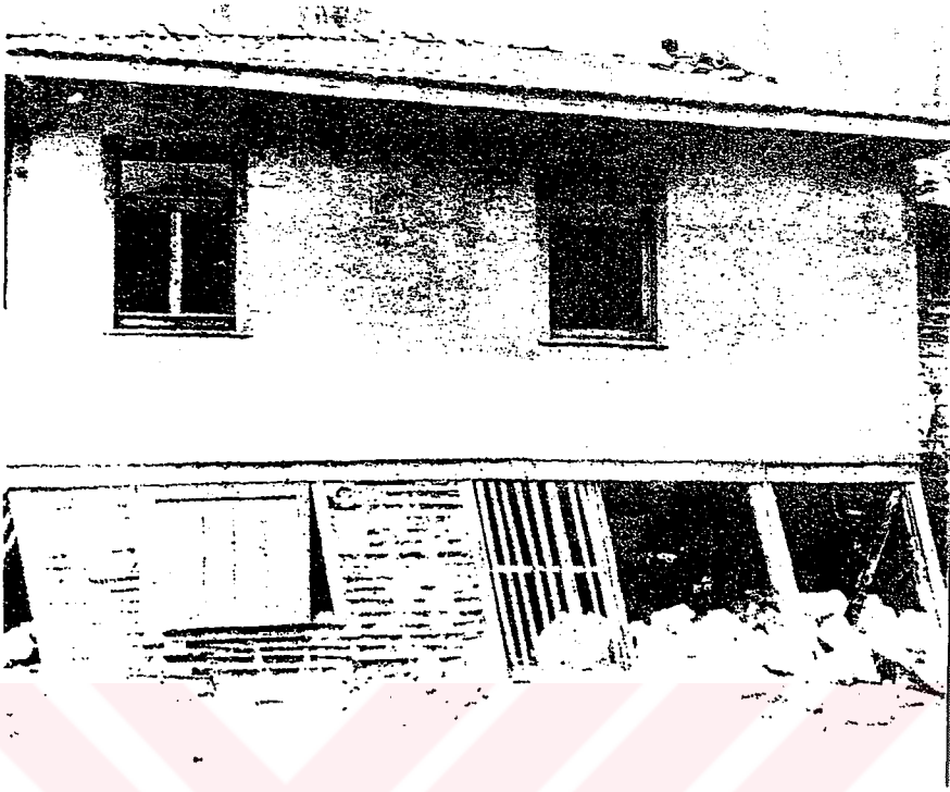
Şekil D.46 1970Gediz depremi, yumuşak kat nedeniyle yapının hasar alması (Yarar vd., 1970: 43 )
