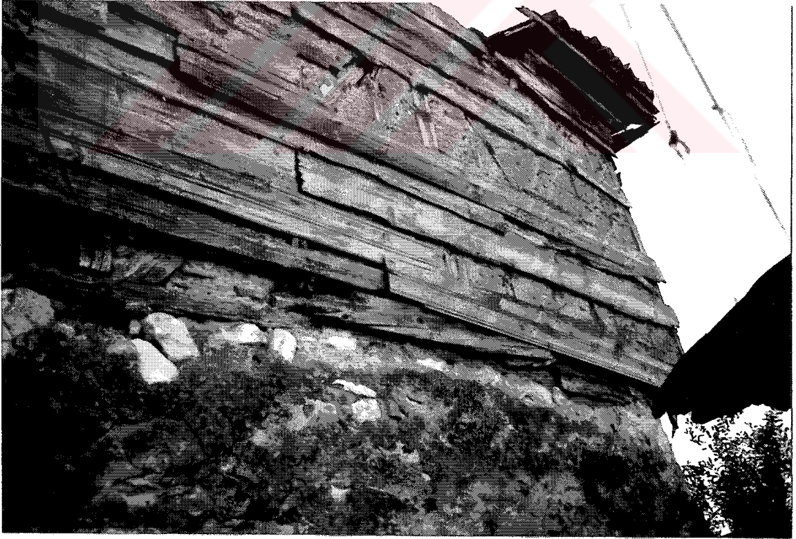
Şekil E.141 Gebze Tavaşancıl, tuğla ve dal örgü dolgunun üzerinin ahşap kaplanmasına örnek
