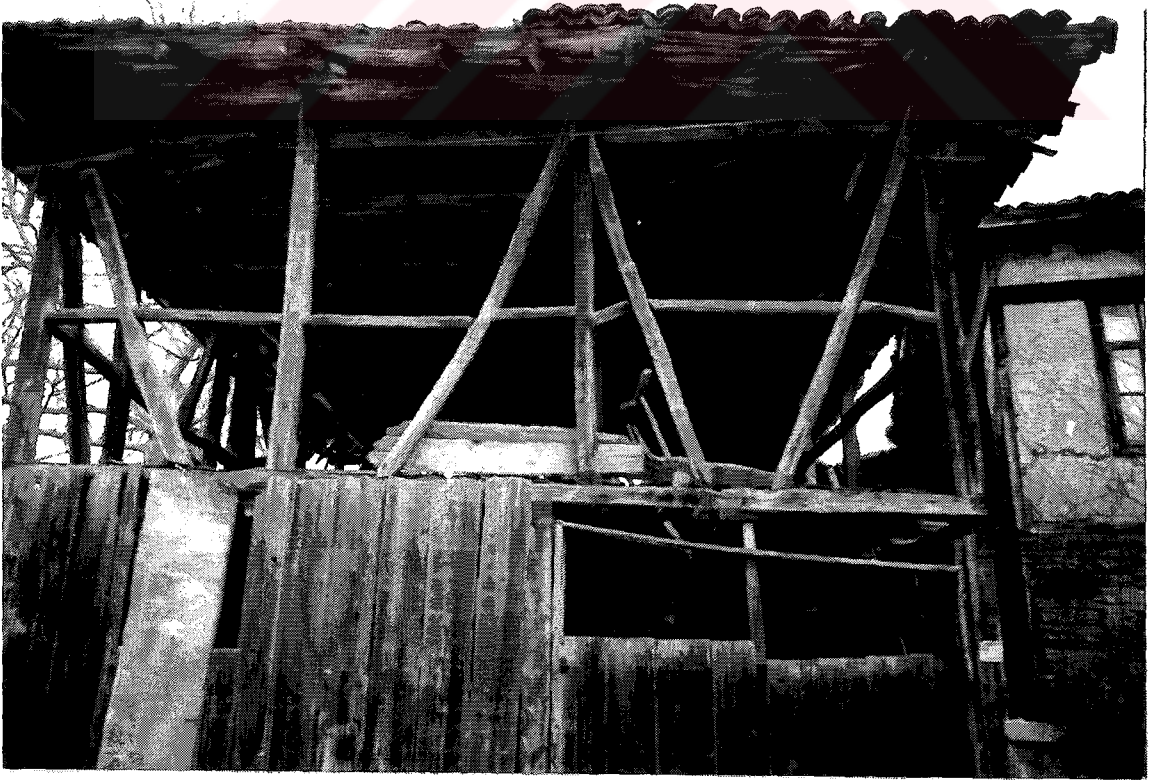
Şekil E.86 Ahşap iskelet sisteminde payandaların yerleştirilmesi
