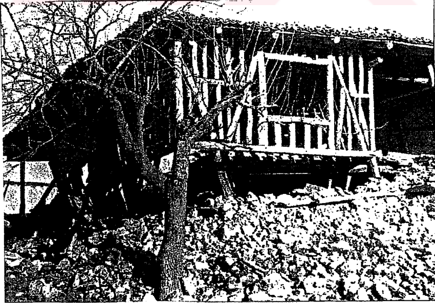
Şekil D.29 1894 Depremi, Burgazada, dolgusu dökülmüş bir ahşap iskeletli ev (İstanbul'da vuku bulan Büyük Hareket'i Arz'a Ait Albümler, Atatürk Kitaplığı, Nr. 184. 2/44 )
