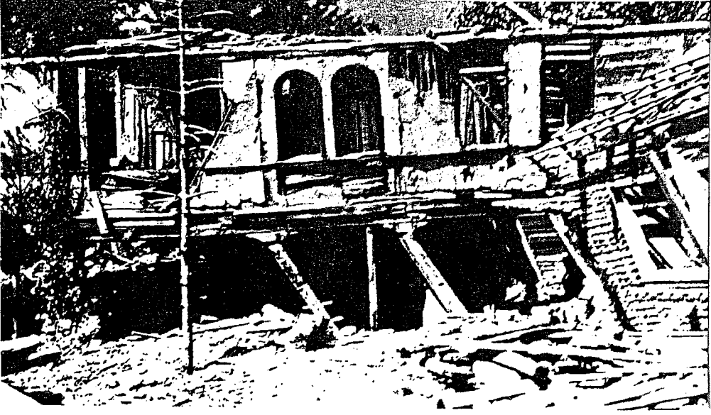
Şekil D.44 1967 Depremi, Sığırlıköy’de yumuşak kat hasarı olan bir yapı ( Bayülke )
