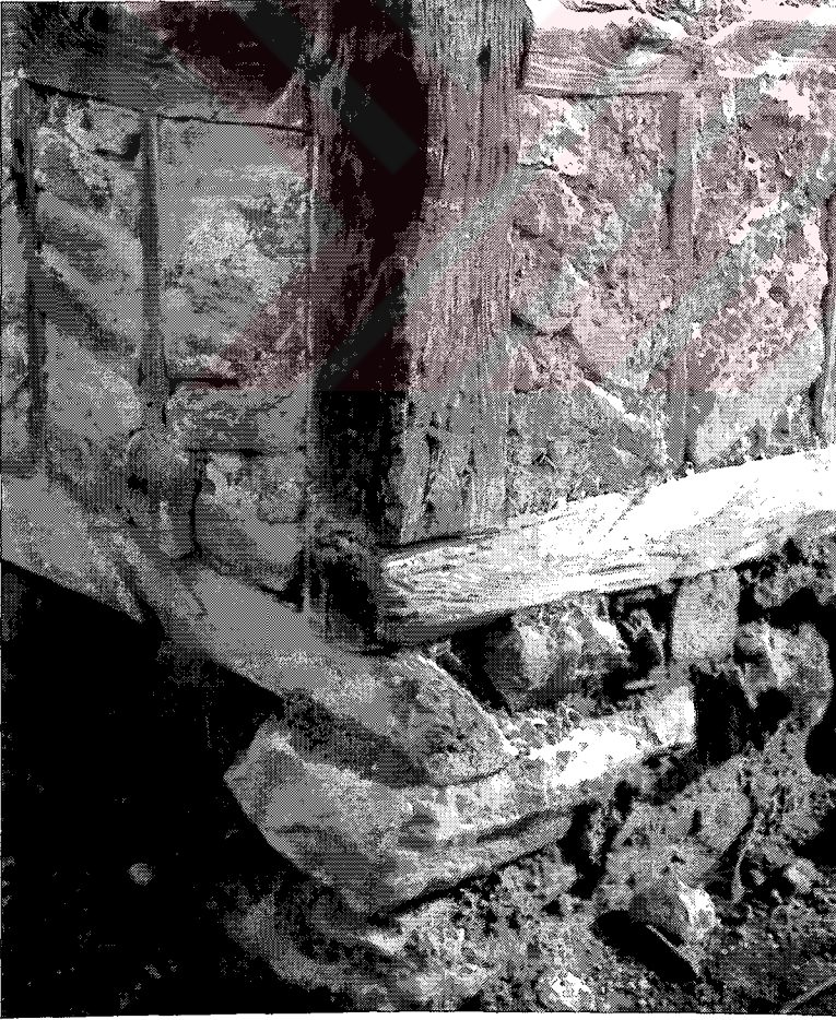
b. Yapı tabanının üst üste bindirilerek oluşturulması
