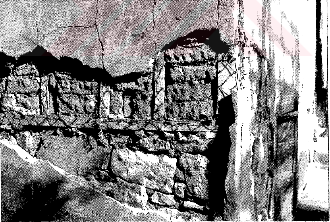
Şekil E.121 Gebze Tavşancıl, ahşap iskelet arasına yatay dizilmiş kerpiç blokları
