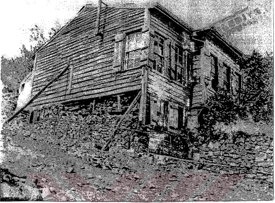
Şekil D.9 1894 Depremi, Kınalıada'da zemin katın taş dolgusunda yıkılma ( İstanbul'da vuku bulan Büyük Hareket'i Arz'a Ait Albümler, Atatürk Kitaplığı, Nr. 184. 2/37 )
