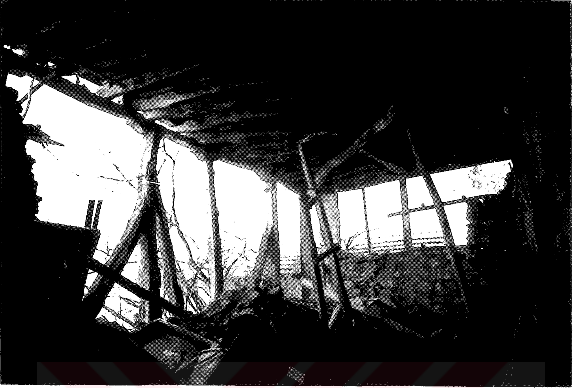
Şekil E.88 Yalova, Denizcalı Köy'ünde ahşap iskelet sisteminde payandaların yerleşimi
