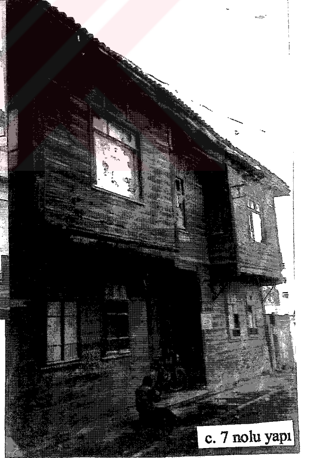
Şekil E.51 Adapazarı, 17 Ağustos 1999 Kocaeli depreminde tümüyle yıkılan ahşap iskeletli yapılar ( KTBKTVK Bursa Bölge Kurulu arşivi )
