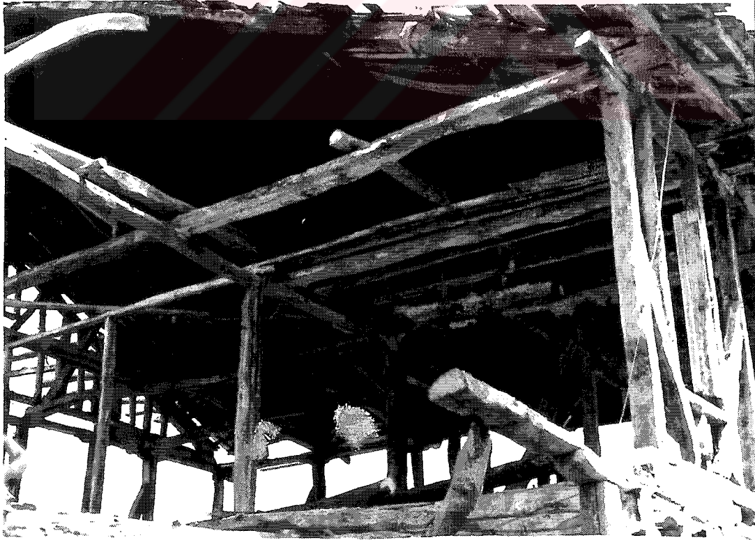
Şekil D.74 Yalova Çukur Köy, depremde çatısının bir bölümü hasar almış yapı
