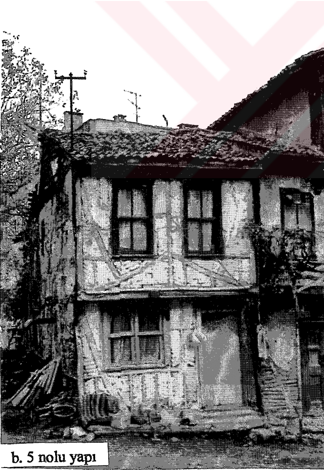
Şekil E.57 17 Ağustos 1999 Kocaeli depreminden sonra Gölcük Değirmendere’de hasar alan ahşap iskeletli yapılar ( Değirmendere Belediyesi arşivi )
