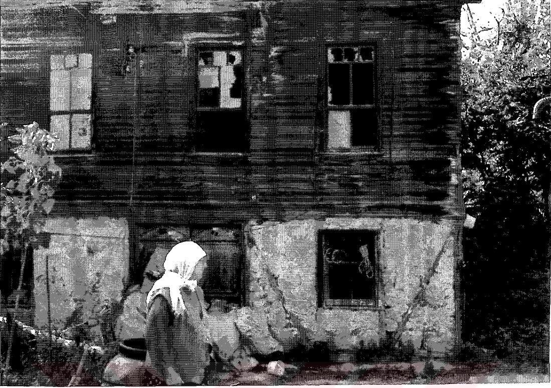
Şekil E.117 Gebze Tavşancıl, zemin katta ahşap iskelet arası taş dolgu
