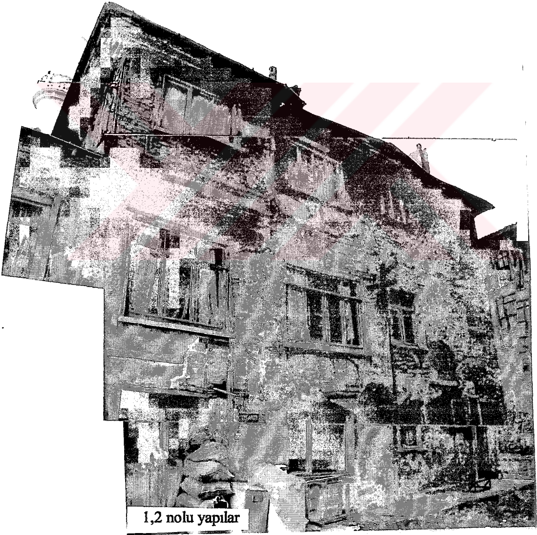
Şekil E.61 17 Ağustos 1999 Kocaeli depreminden sonra Gölcük Değirmendere'de hasar alan ahşap iskeletli yapılar ( Değirmendere Belediyesi arşivi )
