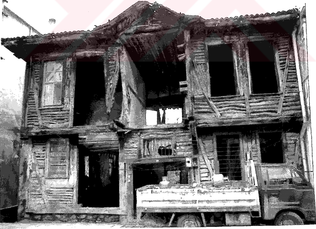
Şekil E.128 Ahşap iskelet arasının kabaca biçimlendirilmiş ahşap ile doldurulması
