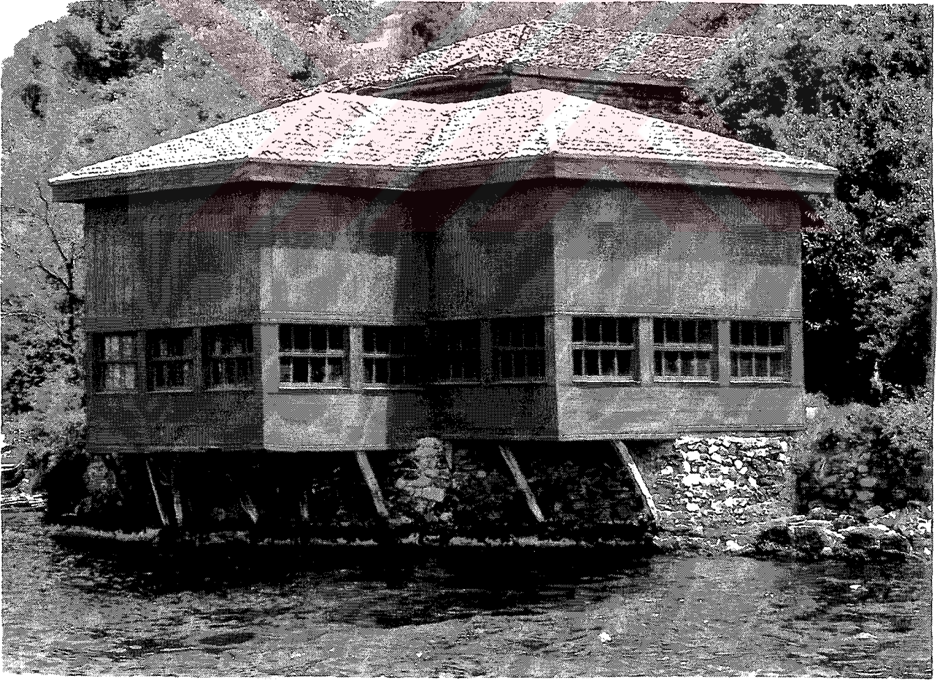
Şekil B.12 : Ahşap kaplamalı yapı örneği, Amcazade Hüseyin Paşa yalı ( 1699 ) ( Günay, 1999:25, Kuban, 1995: 83 )
