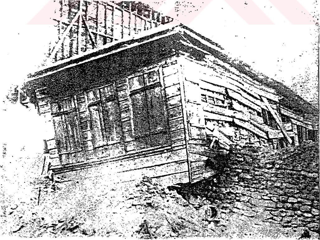
Şekil D.10 1912 Mürefte depremi, zemin katın kargir duvarlarının yıkılması ( Ateş Vd., 1976, foto 1 )
