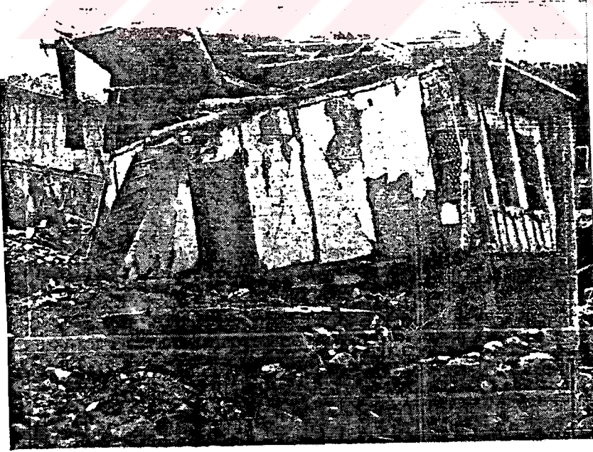
Şekil D.12 1944 Gerede-Çerkeş depremi, zemin katın yıkılması nedeniyle üst katta çökme ( Kafesçioğlu, 1955: 127 )
