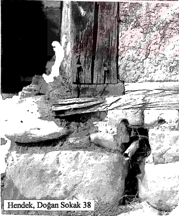
Şekil E.63 Bölgede uygulanan tekil taş temel örnekleri
