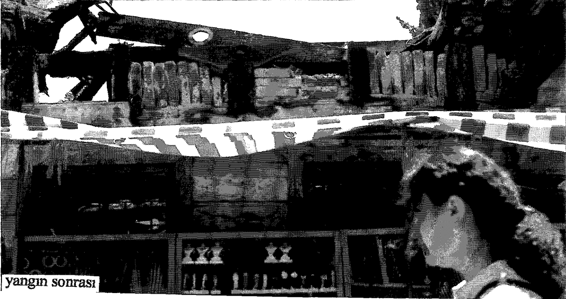
Şekil E.39 Adapazarı, tuğla dolgulu ahşap iskelet üzerine ahşap kaplama örneği
