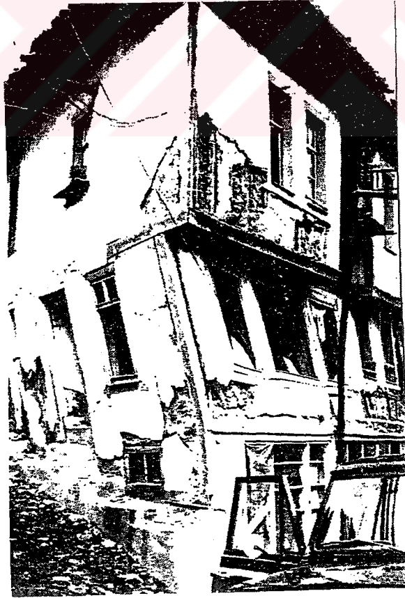
Şekil D.43 1970 Gediz depreminde birinci katında yanıl ötelenme meydana gelen bir yapı ( Yarar vd., 1970: 43 )
