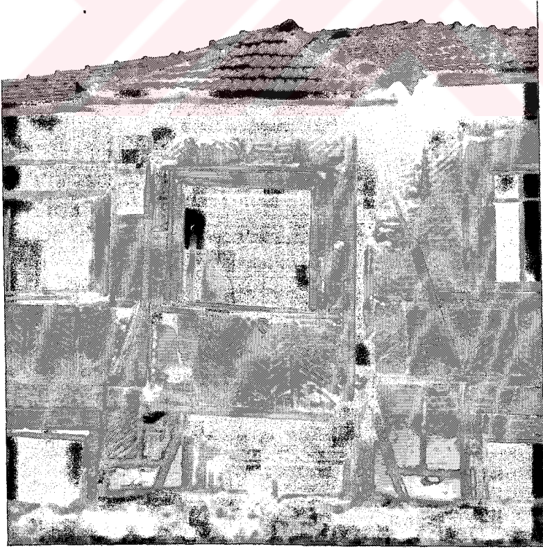
Şekil D.39 Tepetarla, 12 Kasım Düzce 1999 depreminde cumbası hasar almış ev
