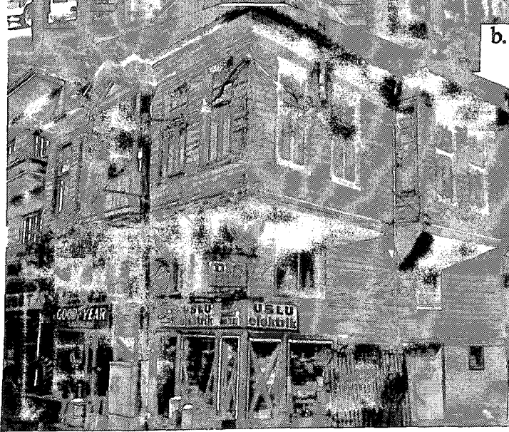
Şekil E.47 Adapazarı, 17 Ağustos 1999 Kocaeli depreminde hasar alan ahşap iskeletli yapılar ( KTBKTVK Bursa Bölge Kurulu arşivi )
