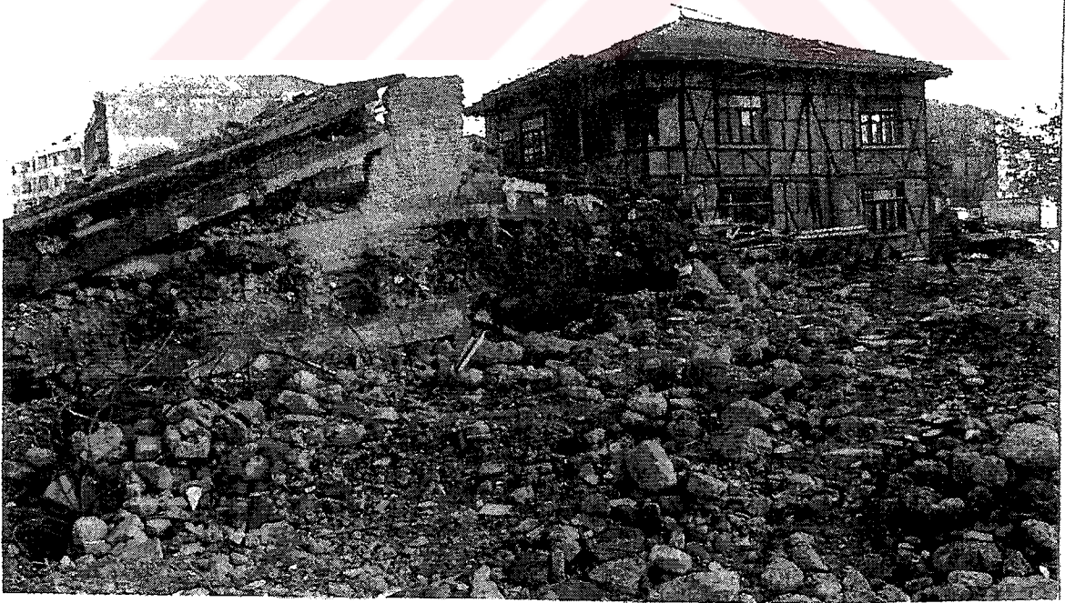
Şekil D.64 Düzce Konuralp, sıva hasarı ve depremi hasarsız atlatan yakın tarihli bir yapı ( Tobriner, 2000: 42 )
