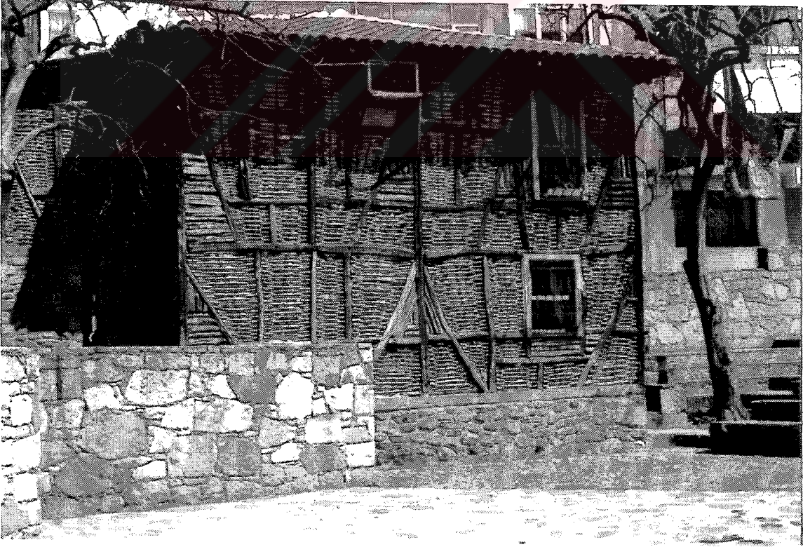
Şekil E.124 Bölgede, ahşap iskelet arasında dal örgü dolguya örnek
