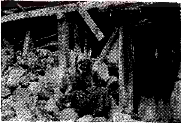
Şekil D.27 Çerkeş 1944, dolgusu dökülmüş ahşap iskeletli yapı ( Kafesçioğlu, 1955: 127 )
