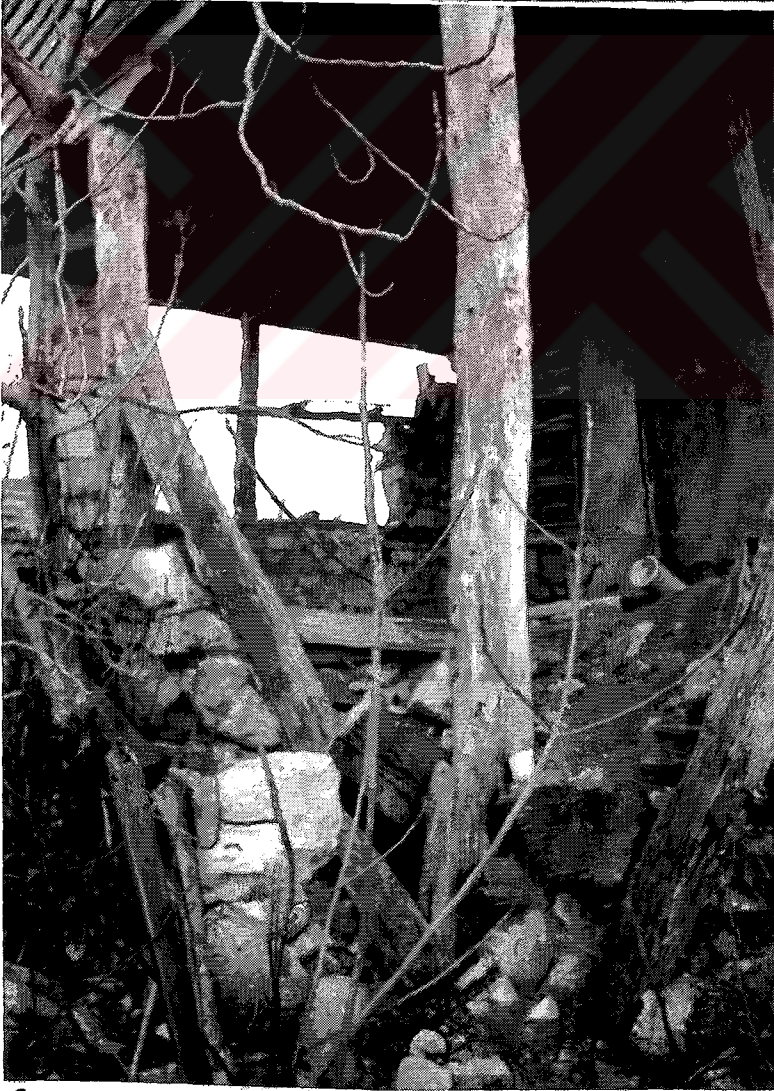
Şekil D.21 Yalova Denizcali Köyü 1999, muhtarın evi arka cephede yıkılan dolgu duvar
