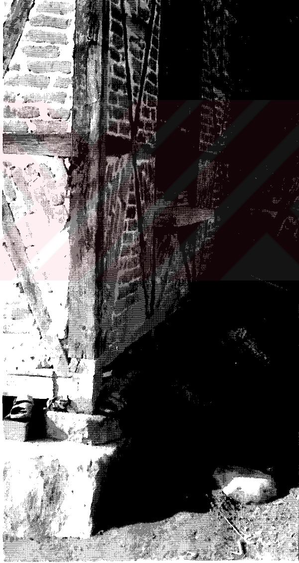
Şekil E.83 Yakın tarihli ahşap iskeletli yapıda alt tabanın bir yönde tek bir yönde çift taban olarak oluşturulması
