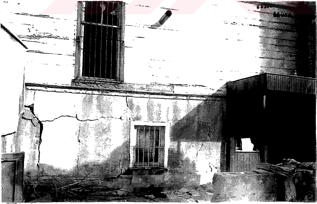
Şekil D.25 Adapazarı 1999, Bahçıvan Sokak No 21, zemin kat duvarında kısmi yıkılmalar oluşan yapı ( KTBKTVK Bursa Bölge Kurulu arşivi )
