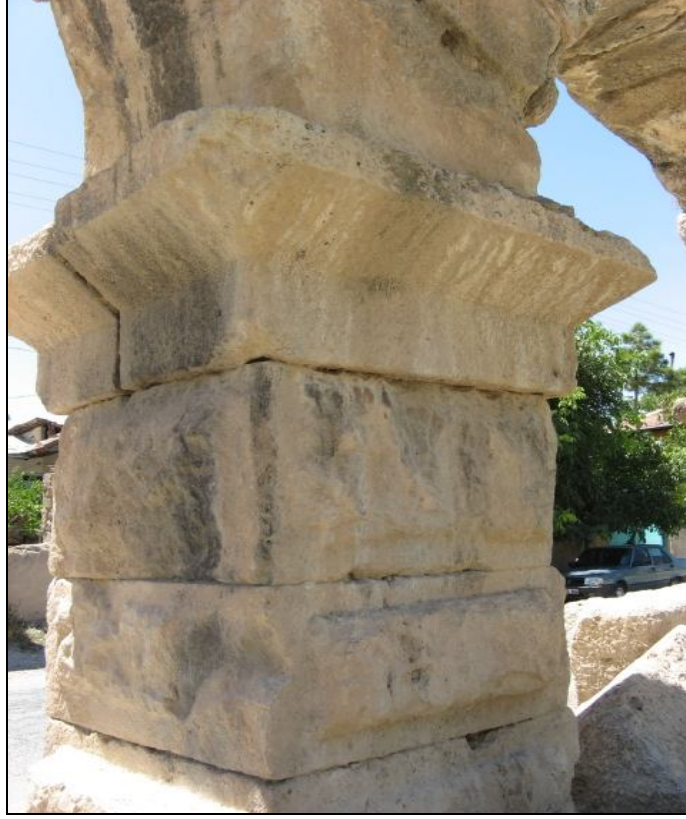
Fotoğraf 3.15 Benzer litolojik ve mühendislik özellikler sunan travertenlerin yapıda taşıyıcı olarak kullanımı
