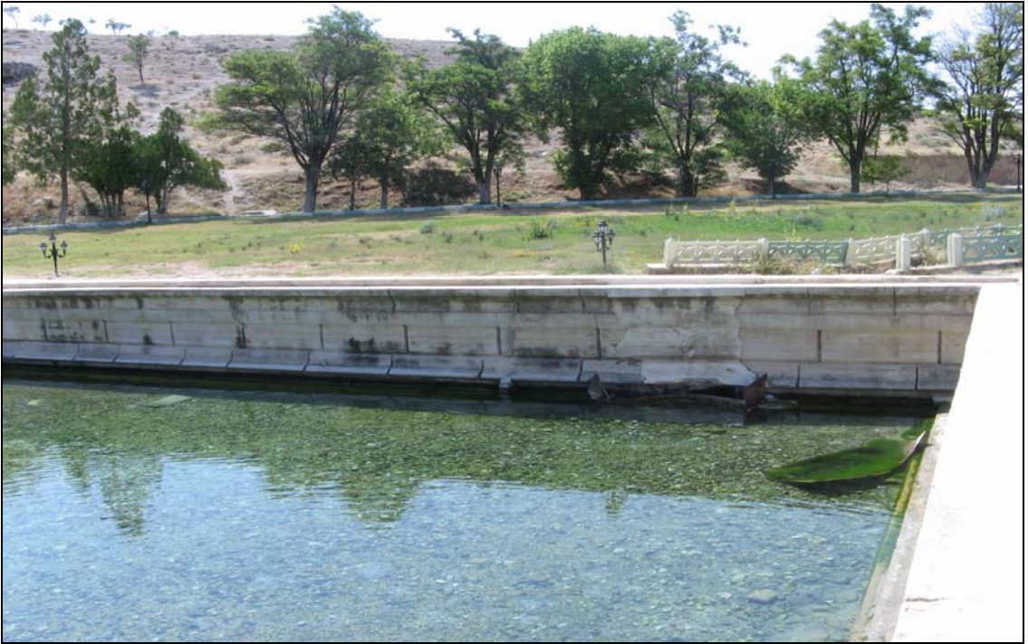
Fotoğraf 3.5 Havuzun güneybatı kesiminde beton malzeme ile benzetim yapılan alandan görünüm
