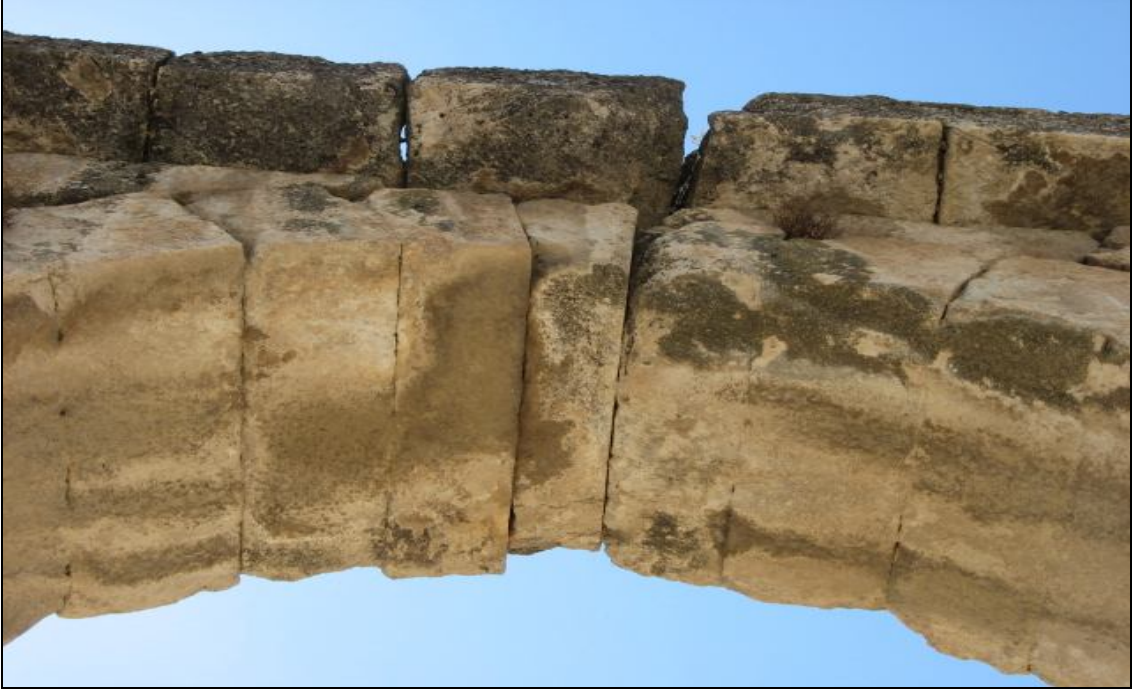
Fotoğraf 3.9 Kemerlerin ayakta kalan kesimden görünüm (kuzeye bakan kesim)
