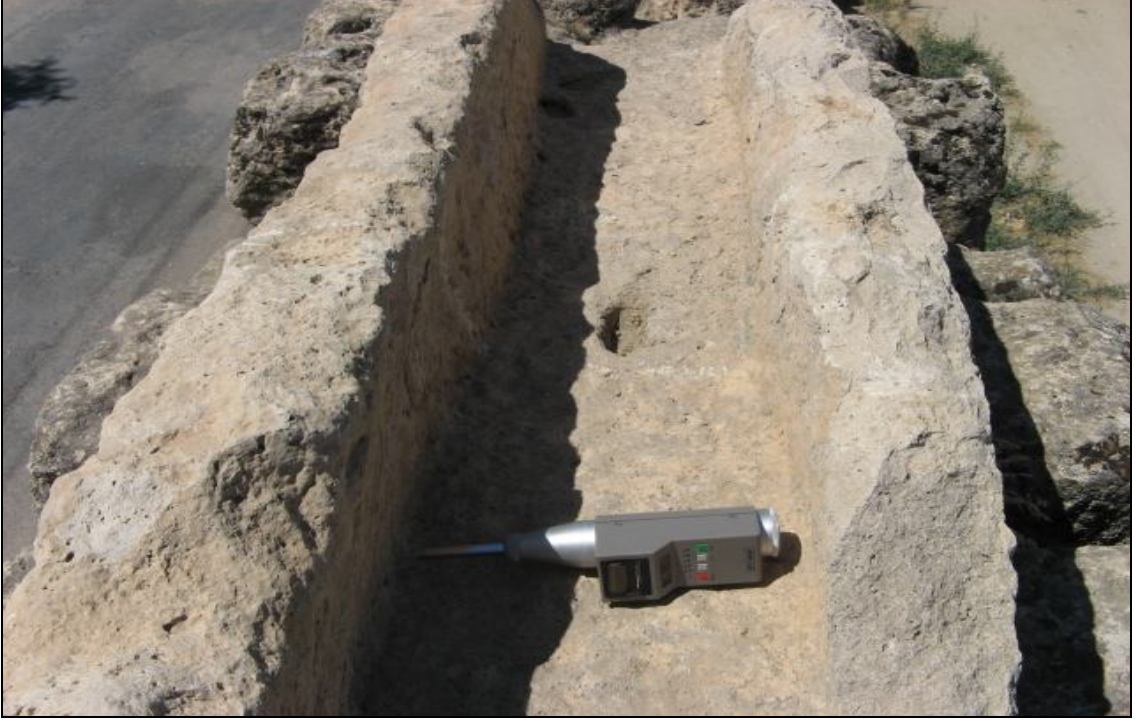
Fotoğraf 3.18 Kemerler üzerinde travertenlerden yapılmış su taşıma kanalının görünümü
