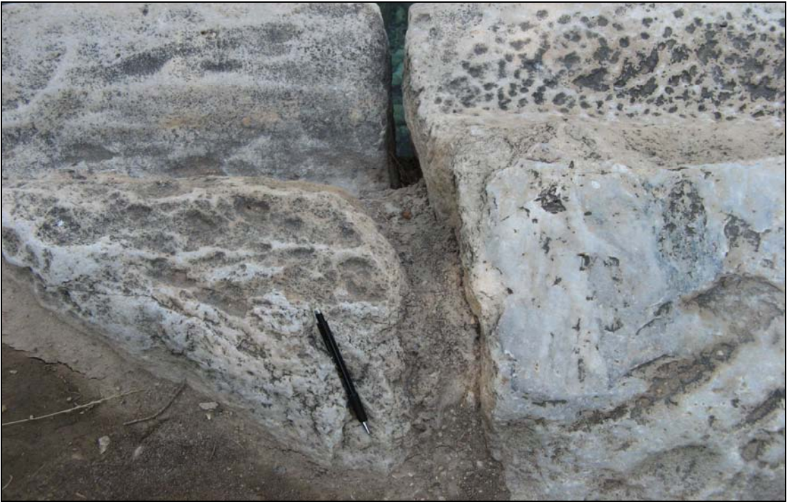
Fotoğraf 3.7 Mermerlerde farklı heterojenlikte kısımların bulunması ve kayaçta farklı derecede ayrışma
