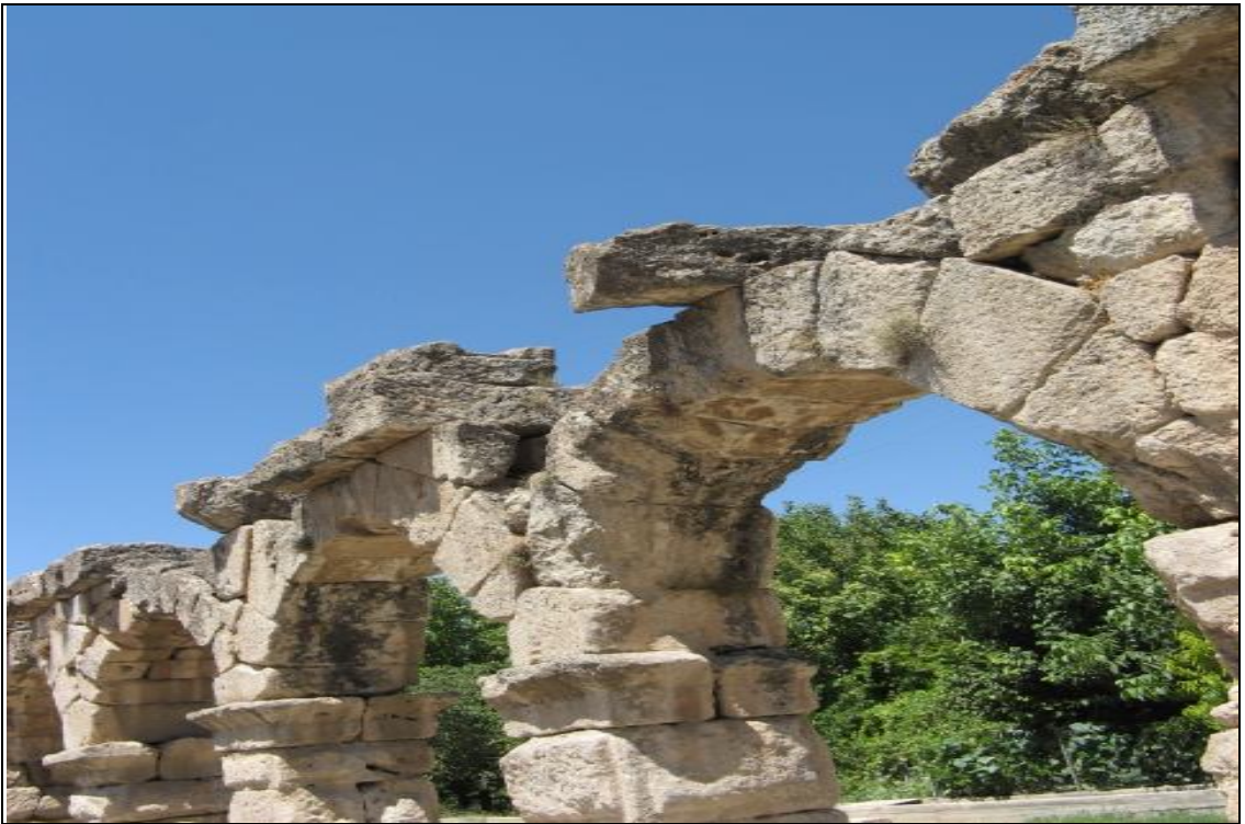
Fotoğraf 3.17 İri boyutlu travertenden yapılmış kemerlerdeki kilit taşı ve yapının görünümü
