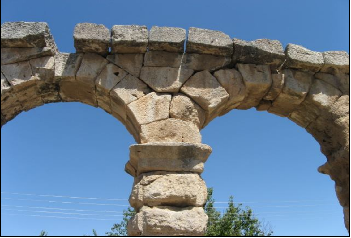
Fotoğraf 3.11 Yapıda kullanılan malzemede farklı derecede ayrışmalara bağlı tahribatın artması
