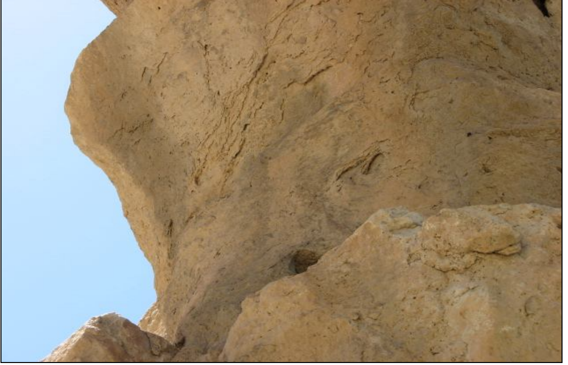
Fotoğraf 3.13 Travertenlerde ayrışma ile oluşan pul pul dökülmelerden bir görünüm
