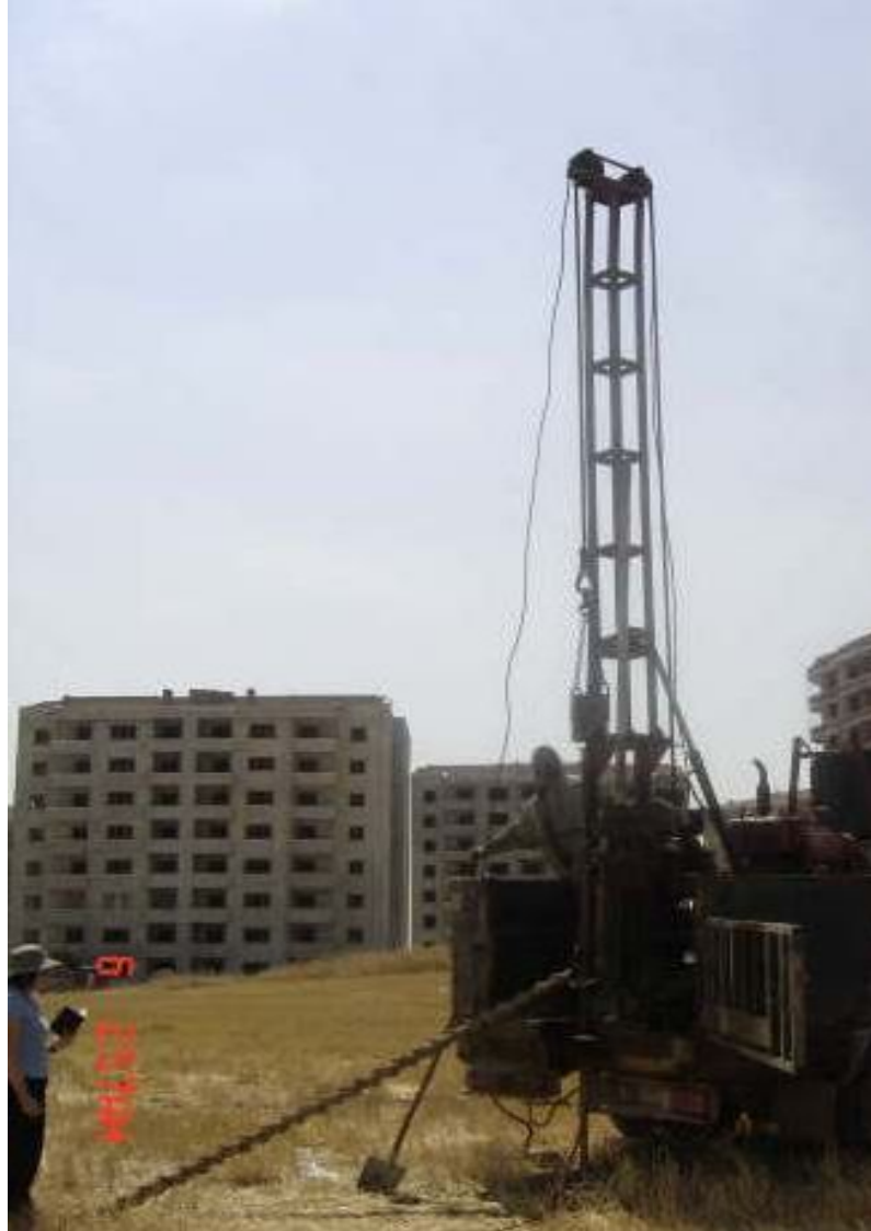
Foto 4.1 Standart Penetrasyon Deneyinin (SPT) yapılışı
