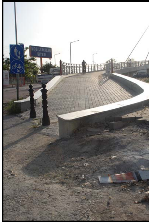
b)Altanlar köprüsü (Konya) araç geçişi için banket yapılmıştır ( Sütiçen arşivinden ).
