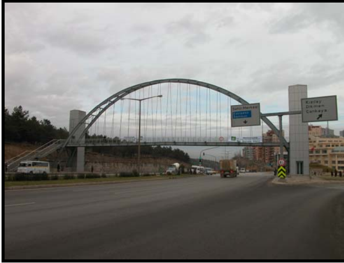
22. Ankara yaya köprüsü (Sütiçen arşivinden).
