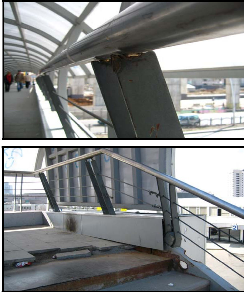
Şekil 92. Merdiven detay hataları Armada önü, Ankara (Sütiçen arşivinden).
