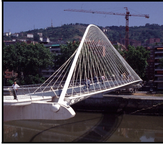
c) Campo Volantin köprüsü, İspanya (Anonim). Şekil 10. Çeşitli yaya köprüleri.
