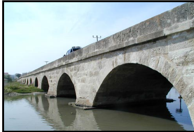
Şekil 17. Silivri Çayı Köprüsü (Anonim).
