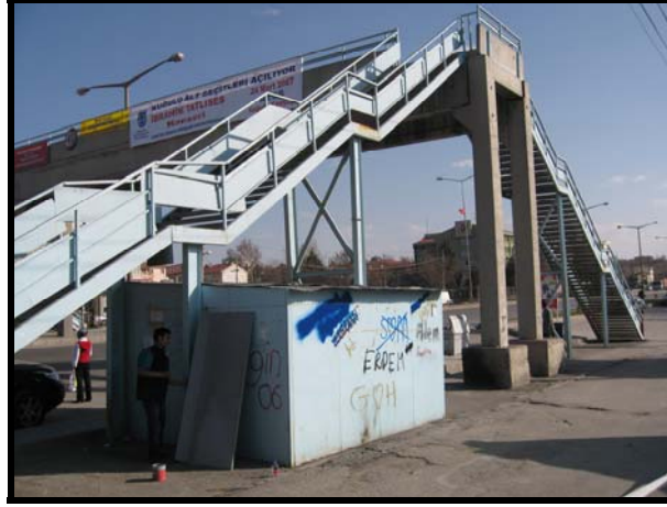
Şekil 27. Taşıyıcı sistemi b.a. merdivenleri çelik malzemeli Gölbaşı köprüsü, Ankara ( Sütiçen arşivinden ).
