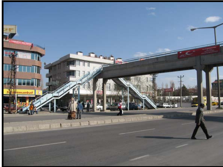
Şekil 45. Gölbaşı yaya köprüsü (Sütiçen arşivinden).
