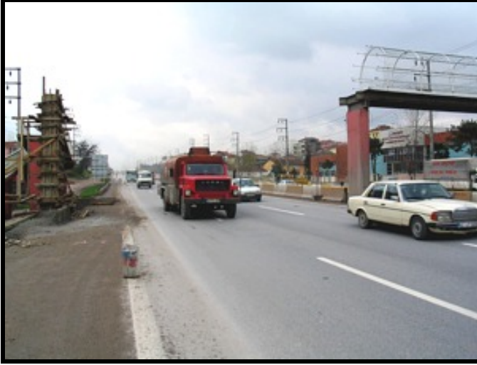
28. Ağır vasıtaların çarpması sonucu oluşan hasarlar ( Anonim ).
