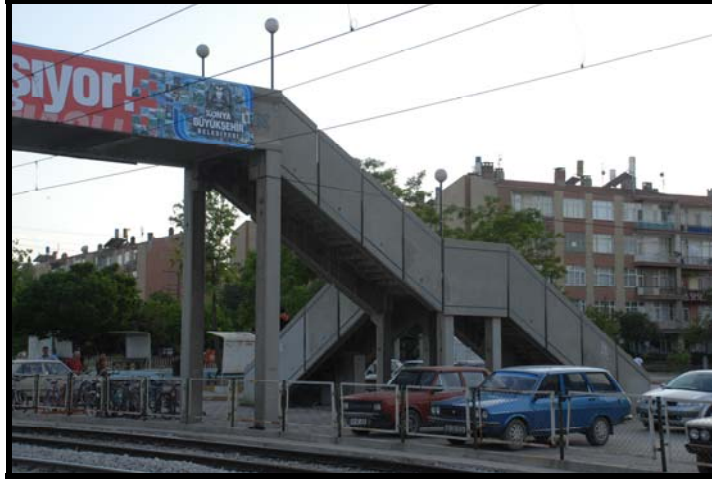
b) Konya Aydınlık Evler yaya köprüsü, betonarme yaya köprüleri (Sütiçen arşivinden).
