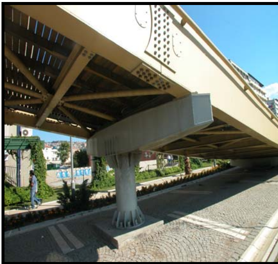
9. Izmir Konak kprs, Tařıcı sistemi elik, dřemesi ahřap malzeme (Stien arřivinden).
