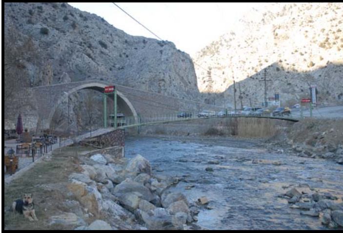
13. Asma yaya köprüsü, Adana (Sütiçen arşivinden).
