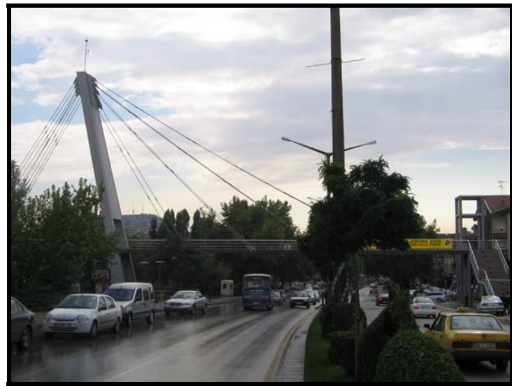
Şekil 47. Ankara’da muhtelif yerlere yapılan yaya köprüleri (Sütiçen arşivinden).
