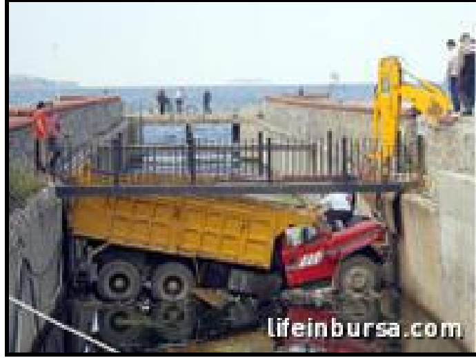
a)Bursa’da yaya köprüsünden geçen kamyon su kanalına düşmüştür ( Anonim ).
