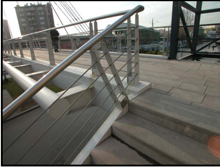
Şekil 93. Merdiven detay ve işçilik için sorunsuz bir uygulama, Ankara ( Sütiçen arşivinden ).
