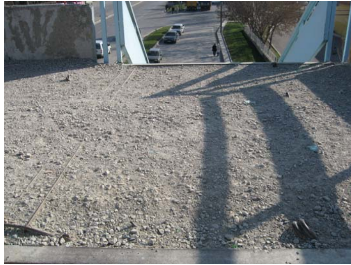
Şekil 69. Donatıda korozyon Gölbaşı örneği (Sütiçen arşivinden).
