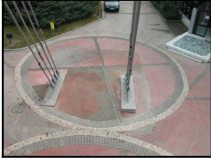
Şekil 96. Taşıyıcı halatlar ve yer kaplaması detay hataları, Altınpark, Ankara (Sütiçen arşivinden).
