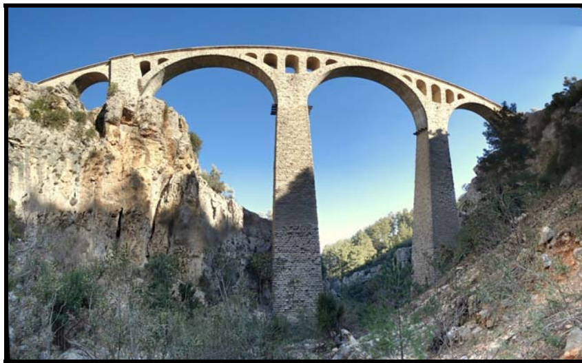
Şekil 5. Hacıkirı demiryolu köprüsü, Adana ( Anonim ).
