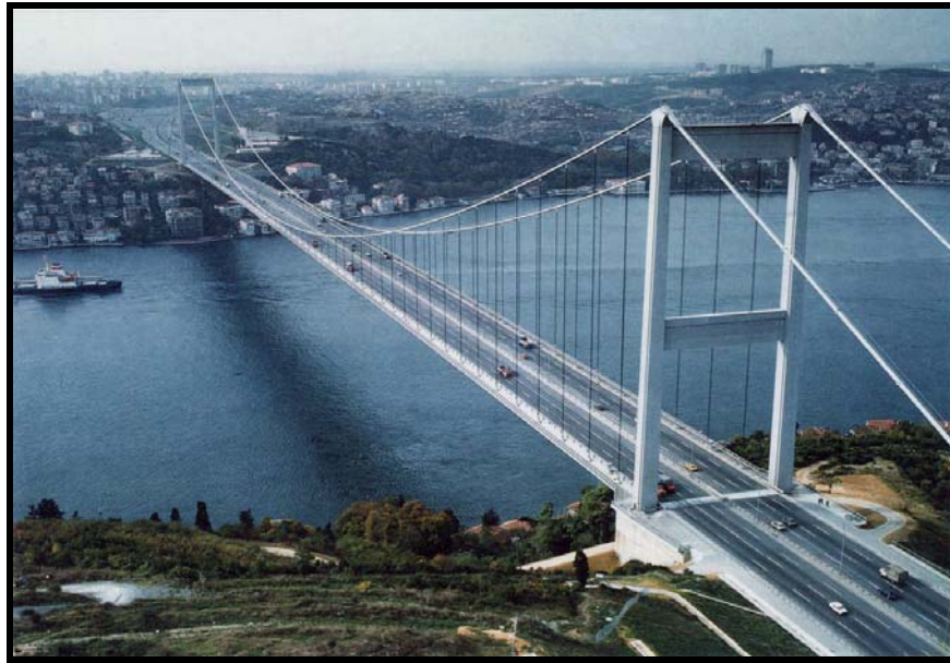
Şekil 3. Fatih Sultan Mehmet köprüsü (Anonim).
