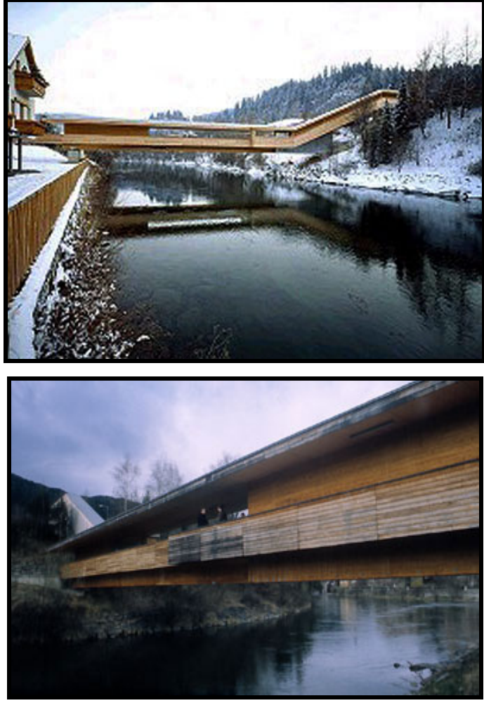
Şekil 15. Mursteg Yaya Köprüsü, Avusturya (Anonim).
