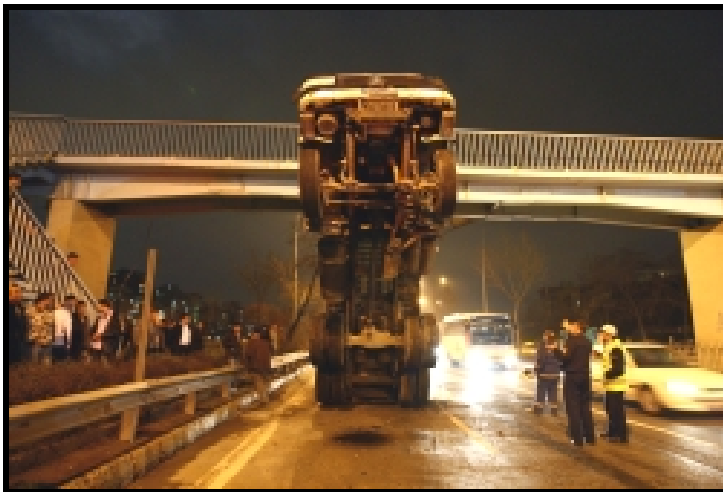
27. Ağır vasıtaların çarpması sonucu oluşan hasarlar (Anonim).
