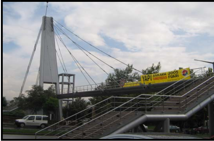
14. Altınpark Önü Yaya Köprüsü, İzmir (Sütiçen arşivinden).
