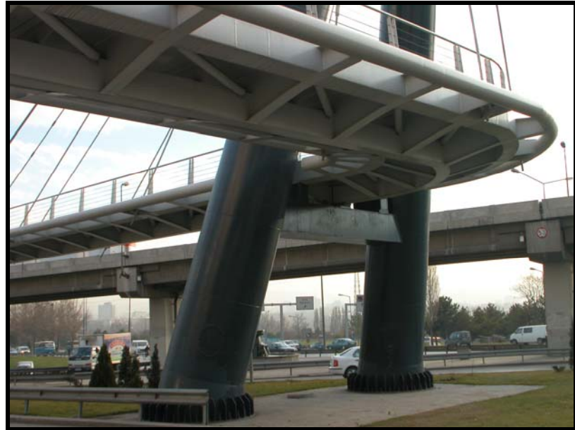
Şekil 98. Taşıyıcı sistemin yer ile birleşimi sorunsuz uygulama, Ankara (Sütiçen arşivinden).
