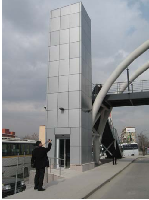
a) Ankara yaya köprüsü. ( Sütiçen arşivinden ).
