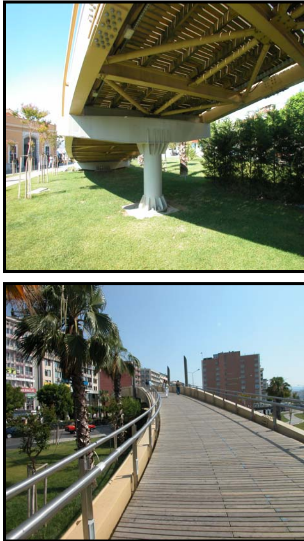
Şekil 26. Tabliyesi ahşap taşıyıcı aksamı çelik malzeme Konak yaya köprüsünün alttan ve üstten görünüşü, İzmir ( Sütiçen arşivinden ).
