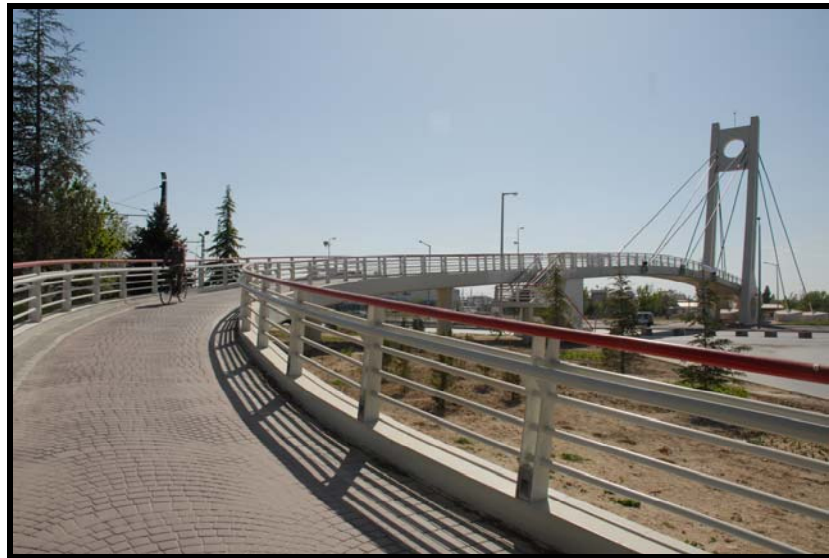
Şekil 8. Altanlar yaya köprüsü, Konya (Sütiçen arşivinden).
