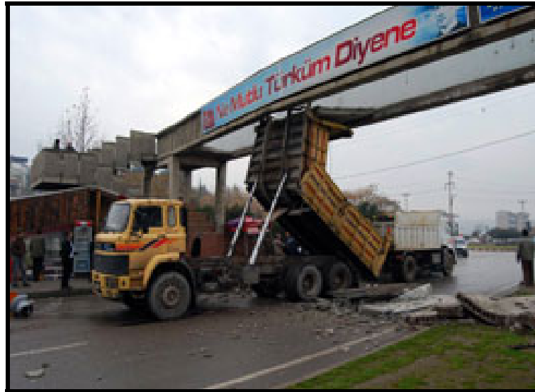
Şekil 48. Ağır vasıtaların çarpması sonucu oluşan hasarlar (Anonim) .
