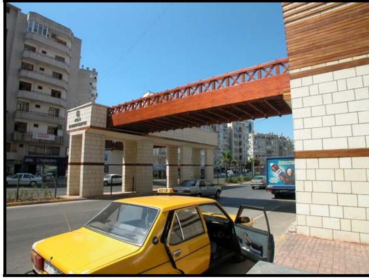
Şekil 16. Ahşap yaya köprüsü, Antalya (Sütiçen arşivinden).
