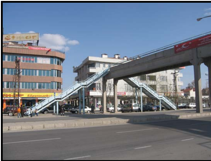
24. Ankara yaya köprüsü (Sütiçen arşivinden).
