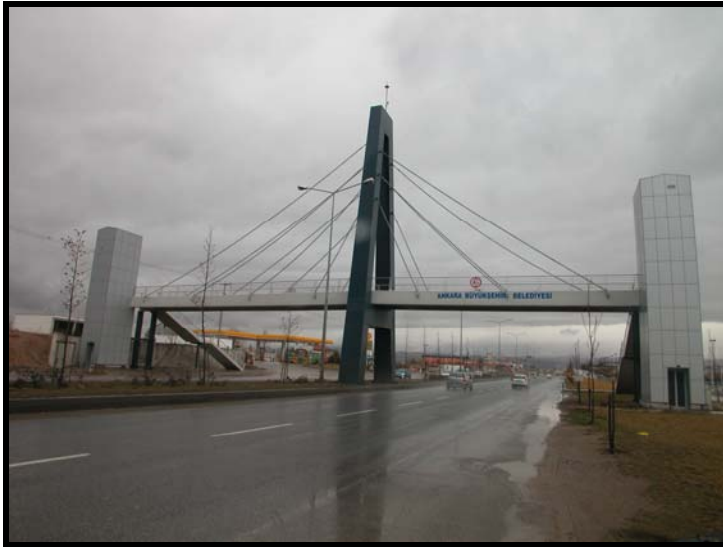
26. Ankara yaya köprüsü (Sütiçen arşivinden).
