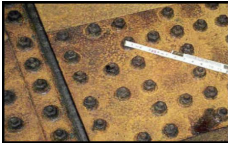
Şekil 77. Aktif korozyon başlangıcı( Sarı-turuncu, Erdal 2005 ).
