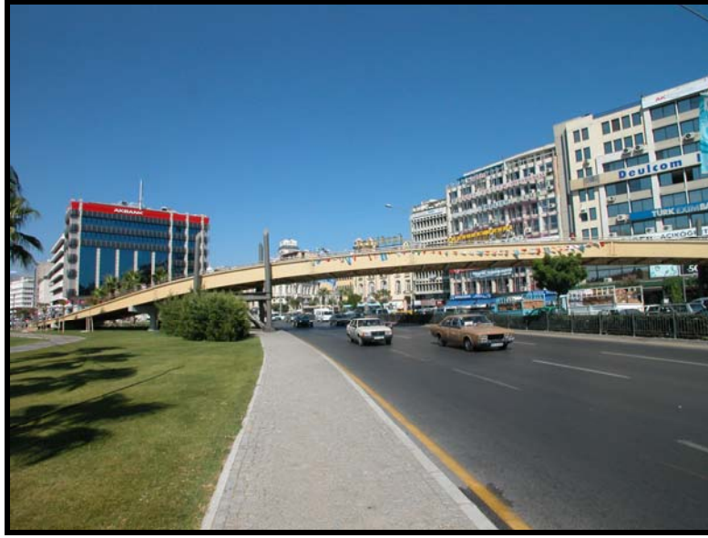
Şekil 46. İzmir Konak meydanı yaya köprüsü (Sütiçen arşivinden).
