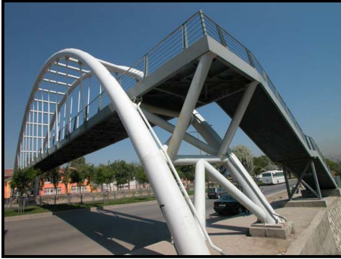
25. Ankara yaya köprüsü (Sütiçen arşivinden).
