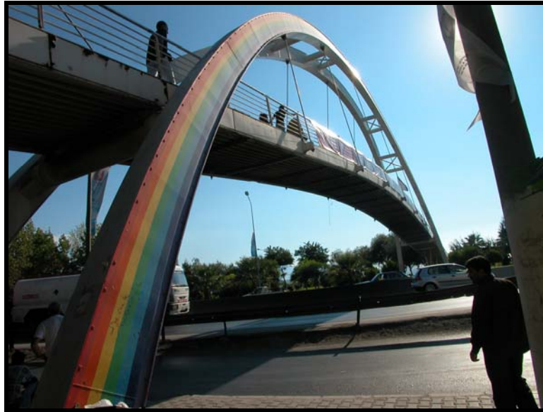
b) Bayraklı Köprüsü, İzmir (Sütiçen arşivinden). Şekil 35. Kemerli yaya köprüleri.
