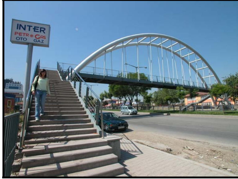
a) Ankara kemerli yaya köprüsü (Sütiçen arşivinden).
