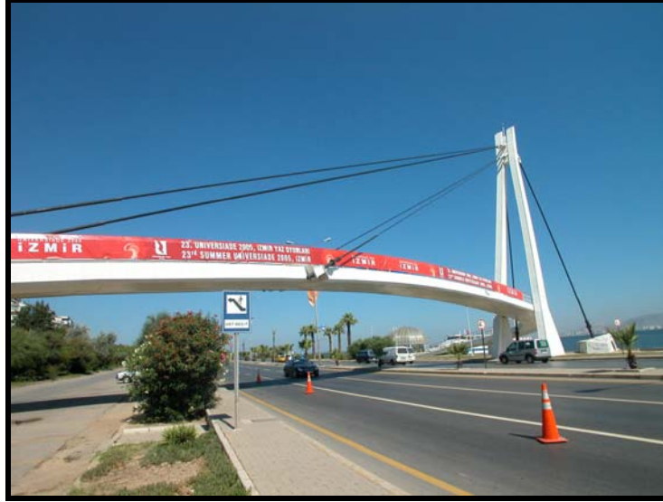
a) Güzelyalı köprüsü, İzmir (Sütiçen arşivinden).
