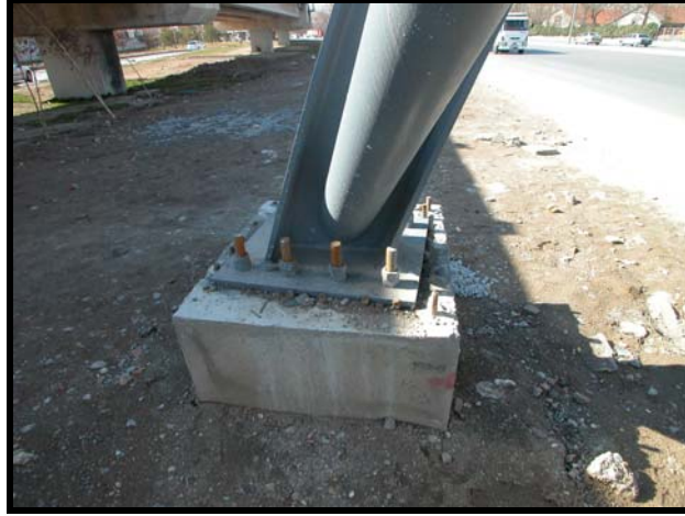
Şekil 96. Taşıyıcı halatlar ve yer kaplaması detay hataları, Altınpark, Ankara (Sütiçen arşivinden).
