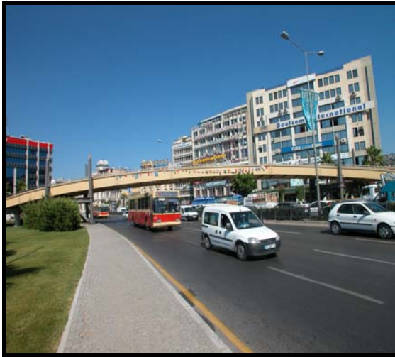
8. Izmir Konak kprs, Tařıcı sistemi elik, dřemesi ahřap malzeme (Stien arřivinden).
