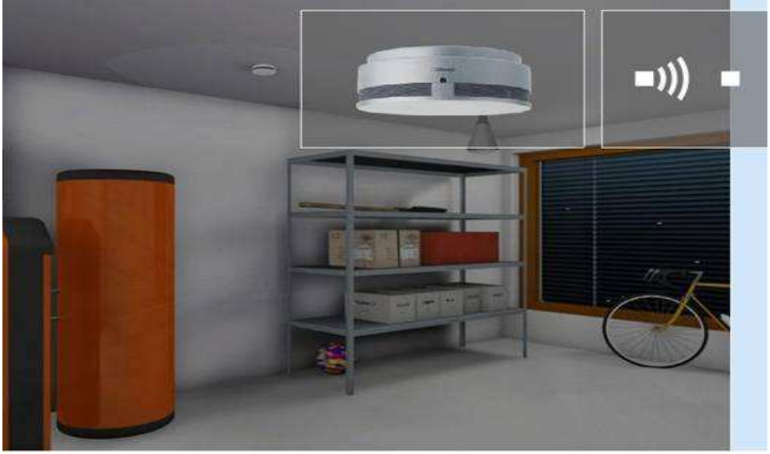
Şekil 3.7. Yangın Dedektör Görünümü
