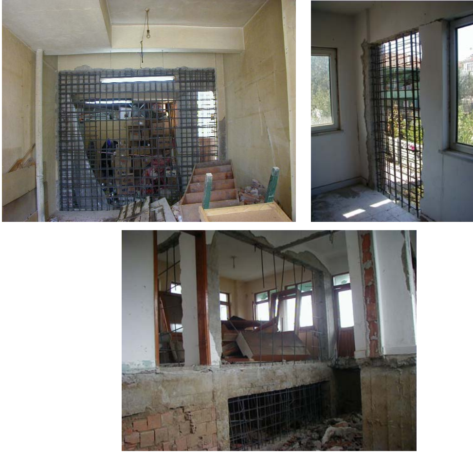
Şekil 1.7 Betonarme perde ilave aşamaları
