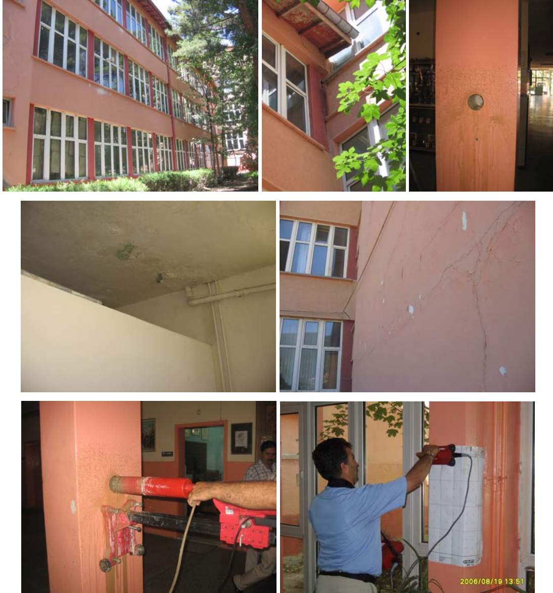
Şekil Ek-4.2 Akşehir Selçuklu Lisesi ile ilgili fotoğraflar
