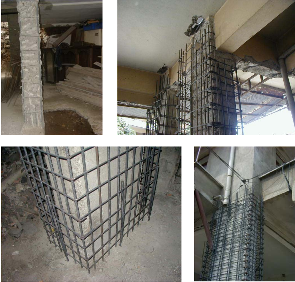
Şekil 1.4 Kolon mantolama aşamaları
