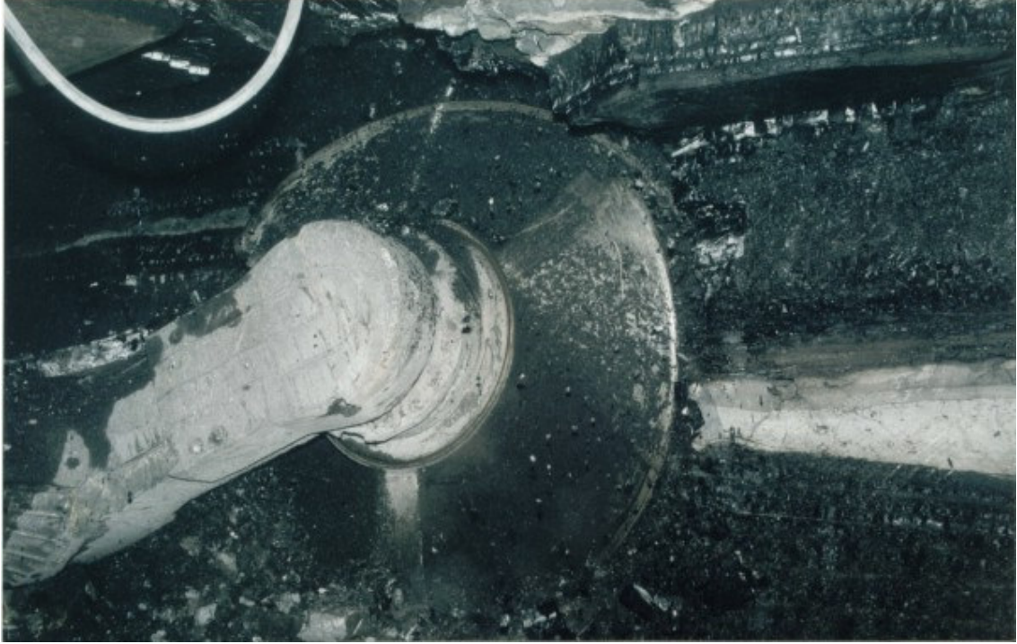
Şekil 4.6. Kesici makine ile ayna kesimi
