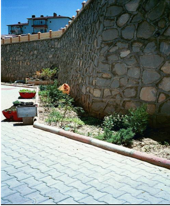
Şekil 4.29. Soğuk görüntü sunan, bitkilendirilmemiş apartman bahçesi çevreleme elemanı
