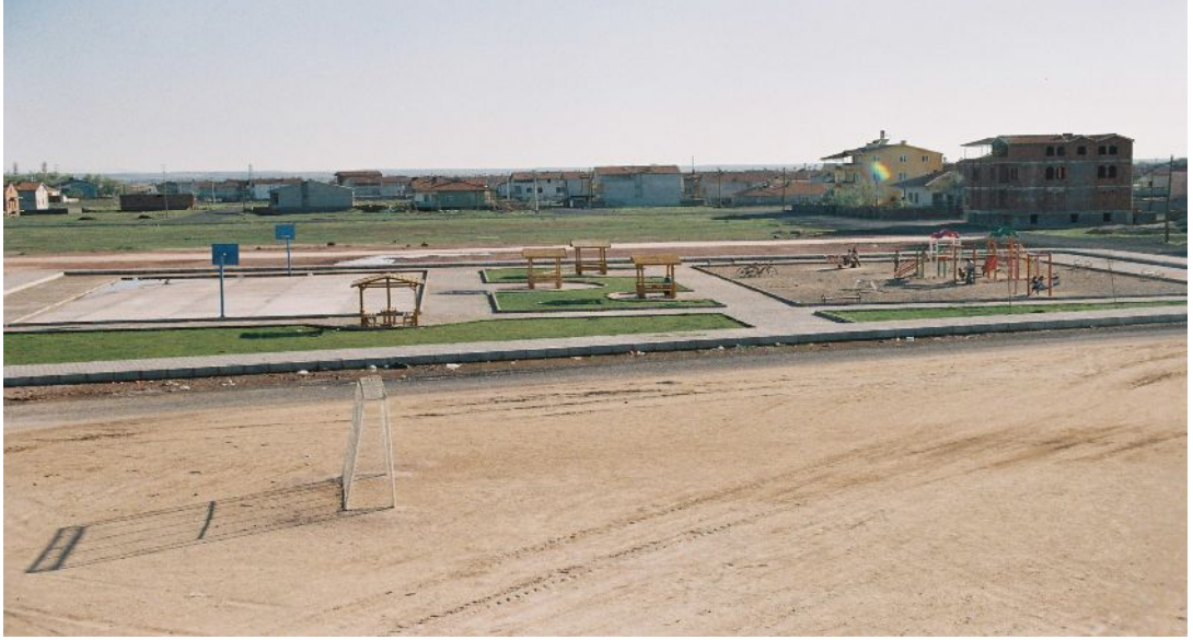
Şekil 4.30. Yeni Toprak Reform Arkası Parkı İçerisinde Yer Alan Mini Futbol ve Basket Sahası (Orişinal 2007).
