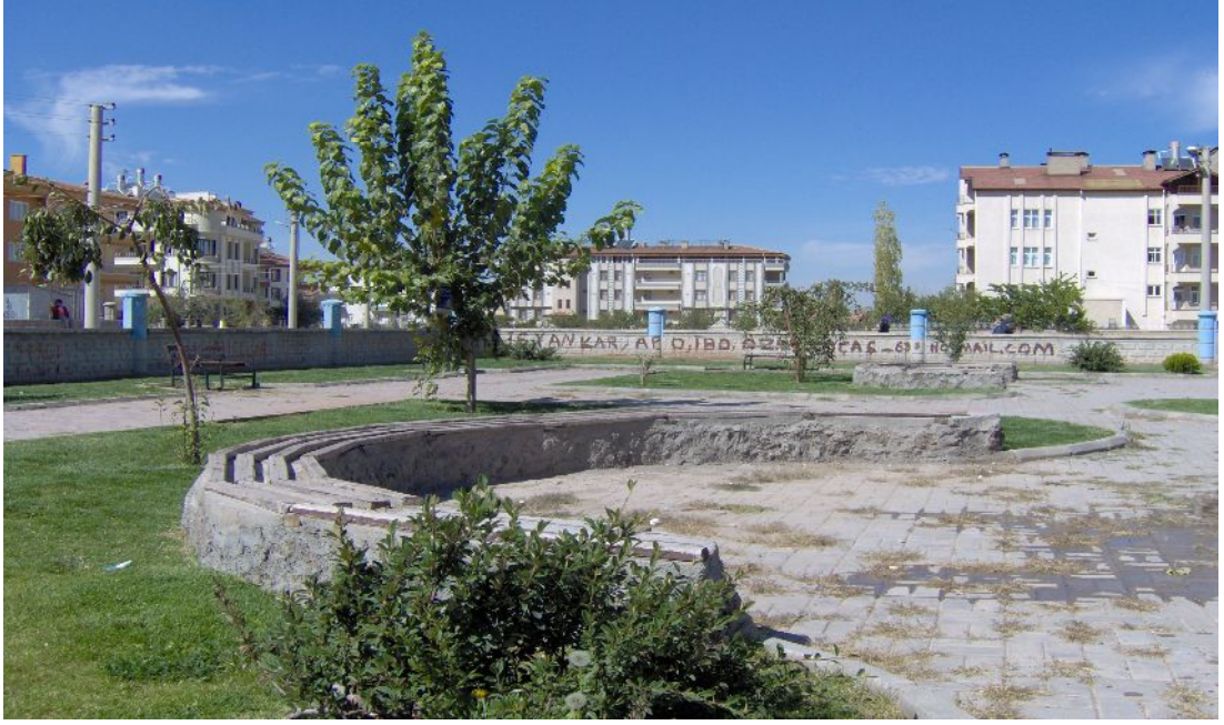
Şekil 4.24. Çok Parkta Kullanılan Beton Duvarlar ve Oturma Grupları Hassas Mahalle Parkından Bir Görünüş (Orijinal 2007).
