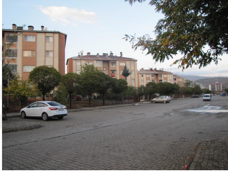
Şekil 4.21. Recep Tayyip Erdoğan Mahallesi TOKİ Konutlarından görünüm (Eylül 2017)
