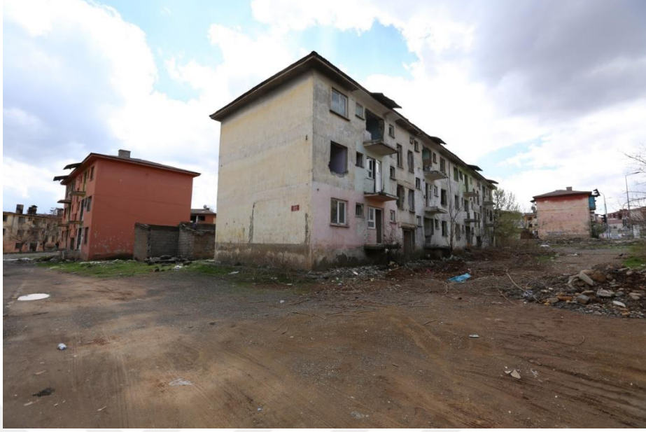
Şekil 4.20. Bingöl kent merkezi Kültür Mahallesi deprem konutlarından görünüm (Nisan 2016)
